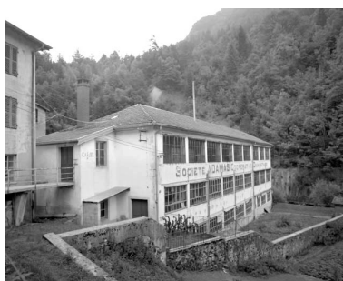
Atelier de fabrication de trois quarts gauche. Phot. Jérôme Mongreville IVR43_19923900438X
