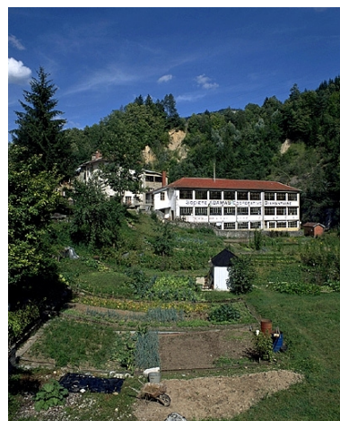
Jardins ouvriers et atelier de fabrication. Phot. Jérôme Mongreville IVR43_19923900435XA
