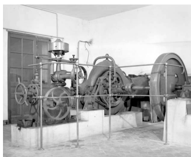
Centrale hydroélectrique : régulateur et turbine du groupe ancien. Phot. Jérôme Mongreville IVR43_19923900459X
