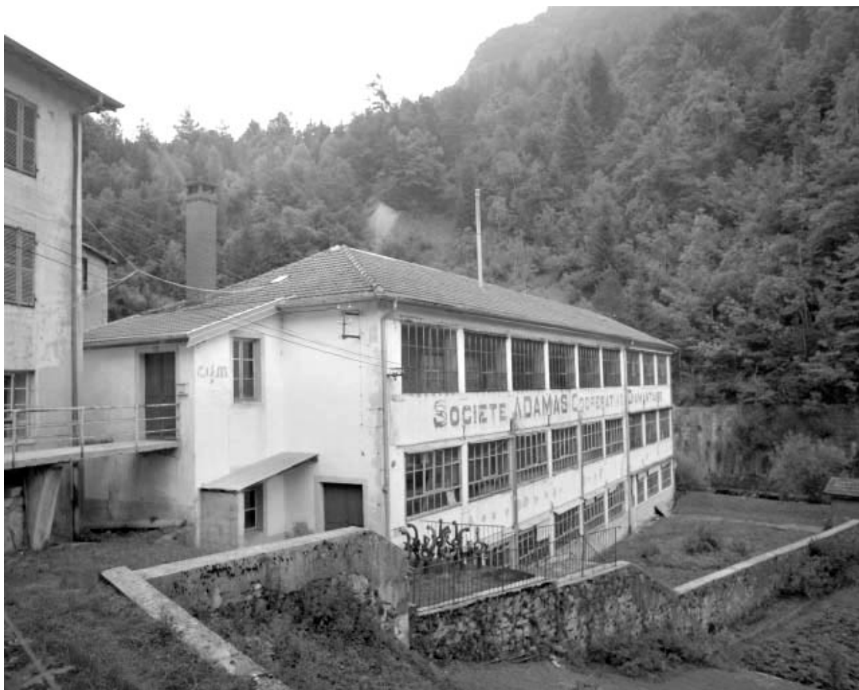
Atelier de fabrication de trois quarts gauche.
