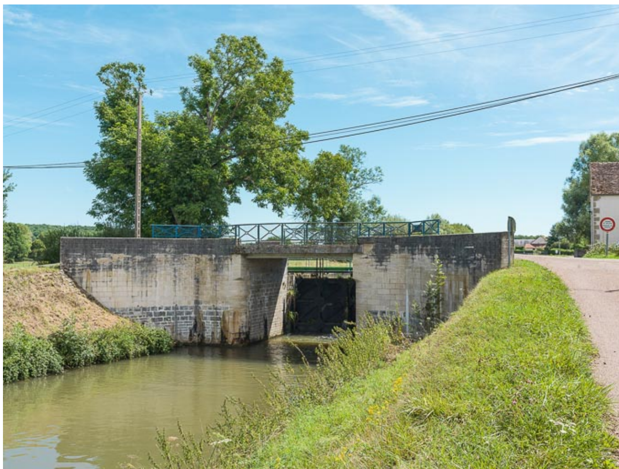
Vue du pont.
