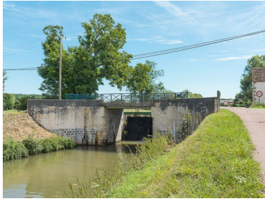
Vue du pont.
