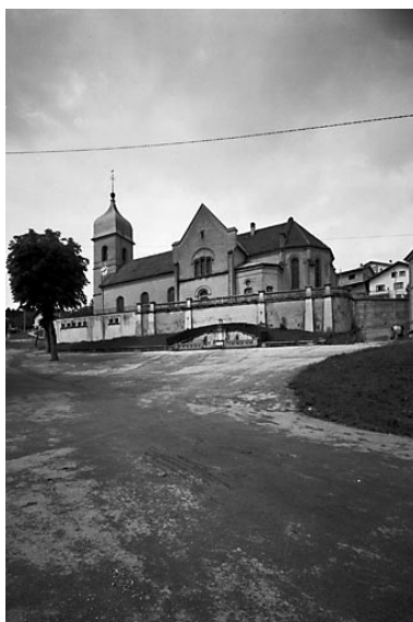
Façade latérale sud. Phot. Yves Sancey IVR43_19752500709V
