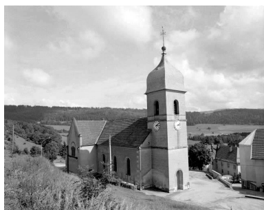
Façade latérale gauche. Phot. Yves Sancey IVR43_19752500707X
