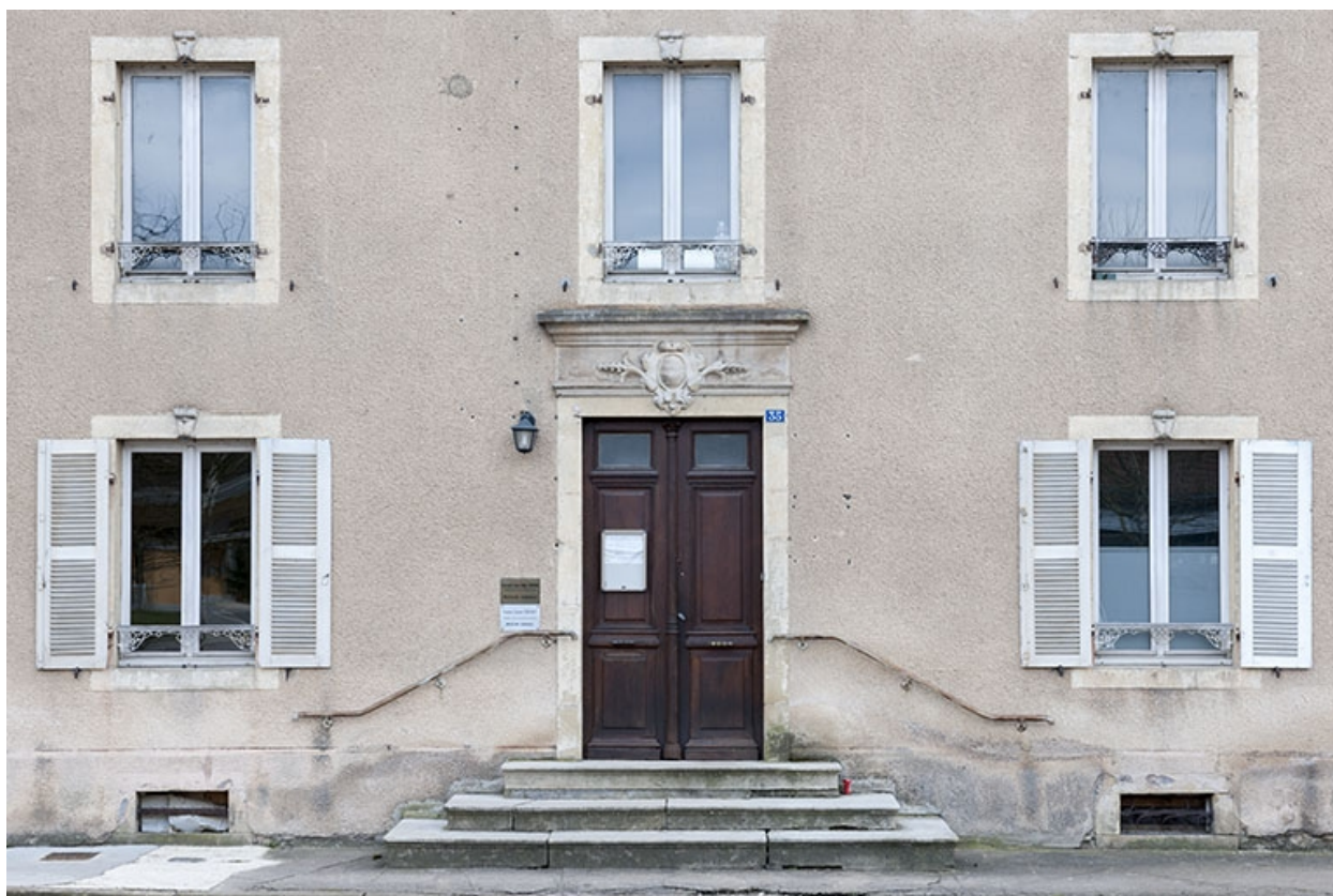
Façade antérieure : baies.
