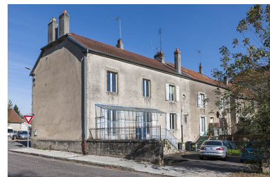
Façade côté jardin. Phot. Jérôme Mongreville IVR43_20127000462NUC4A
