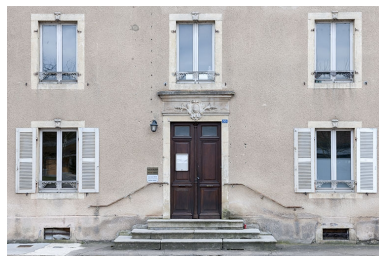
Façade antérieure : baies. Phot. Jérôme Mongreville IVR43_20137000109NUC4A
