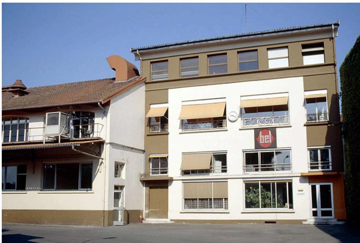
Façade antérieure des bureaux.
