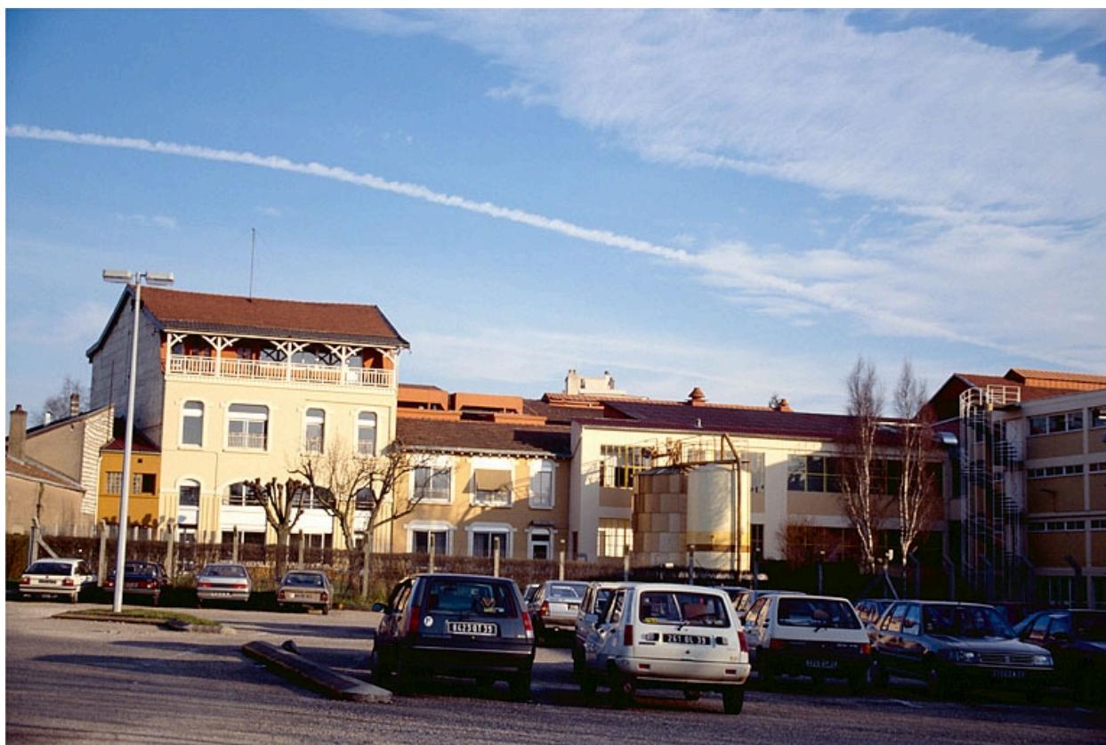
Bureau et atelier de fabrication (E).
