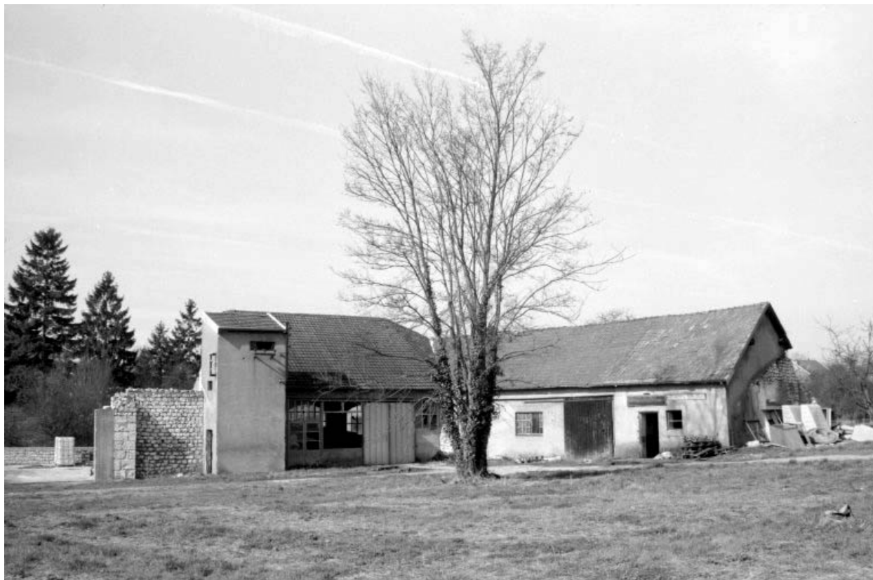
Fabrique d'aliment pour bétail : écuries et transformateur.
