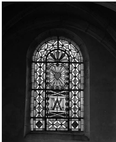
Baie 5 : vue d'ensemble. Phot. Jean-Luc Ligier IVR43_19822500330X
