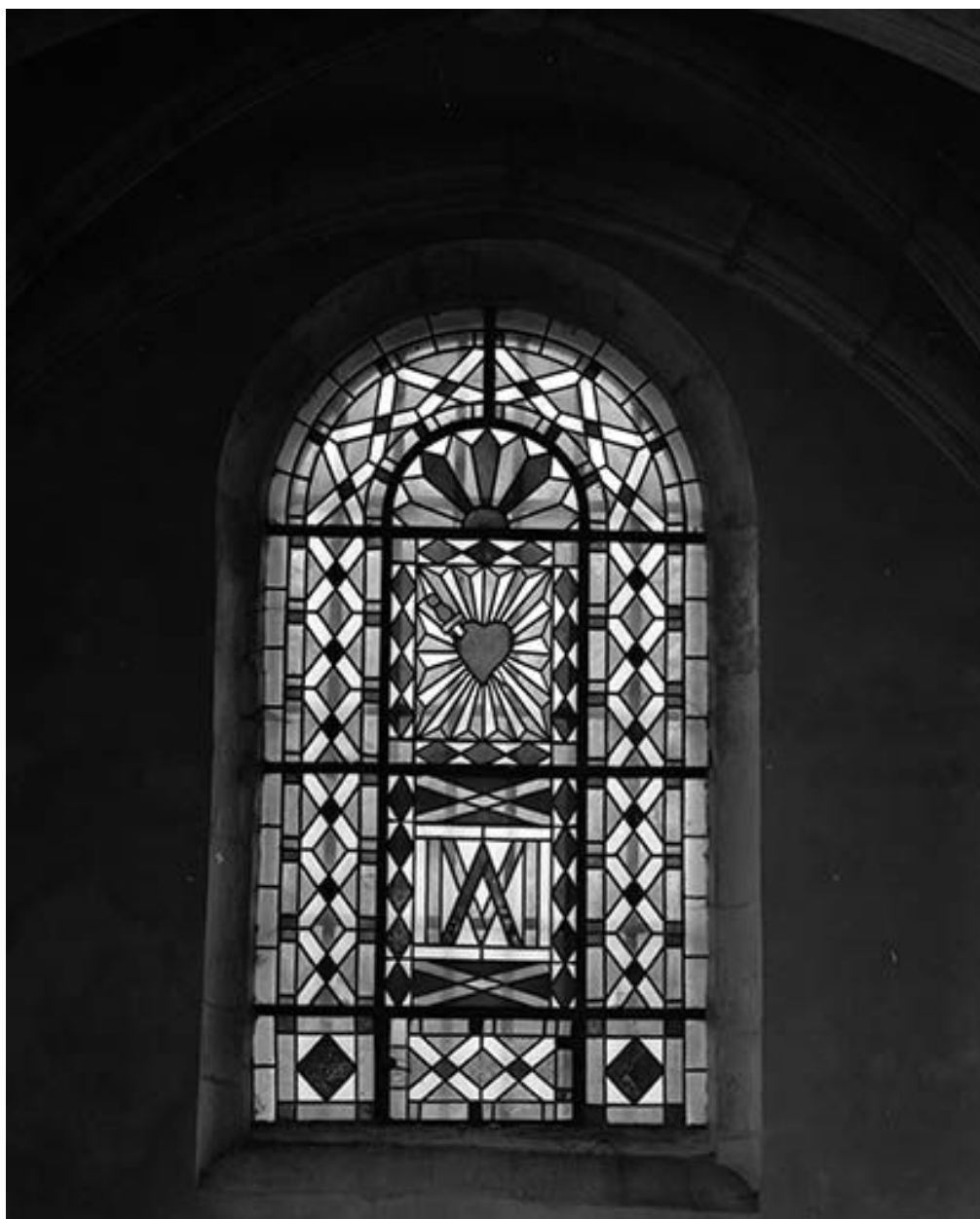
Baie 5 : vue d'ensemble.
