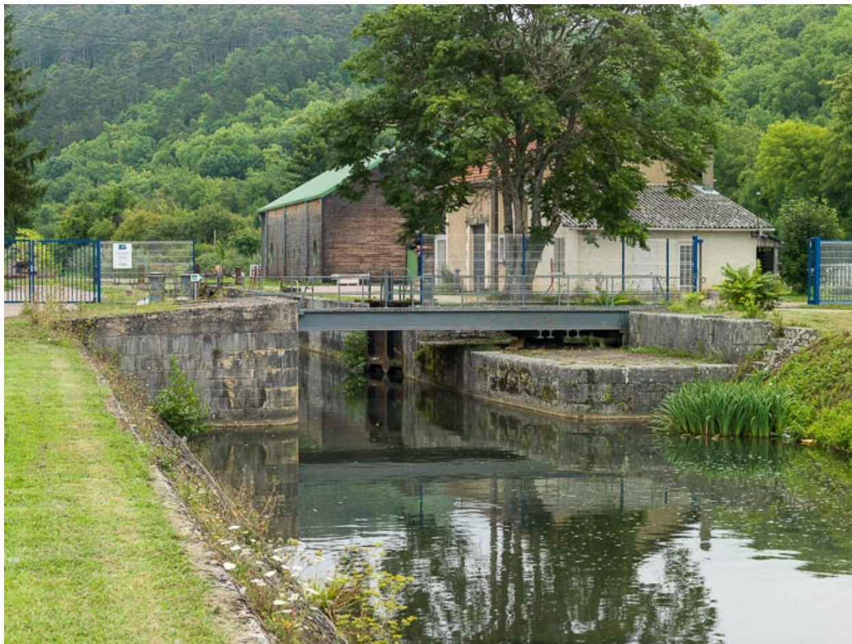
Vue du pont.
