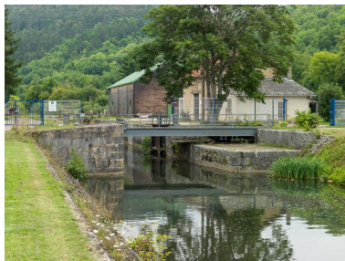
Vue du pont.
