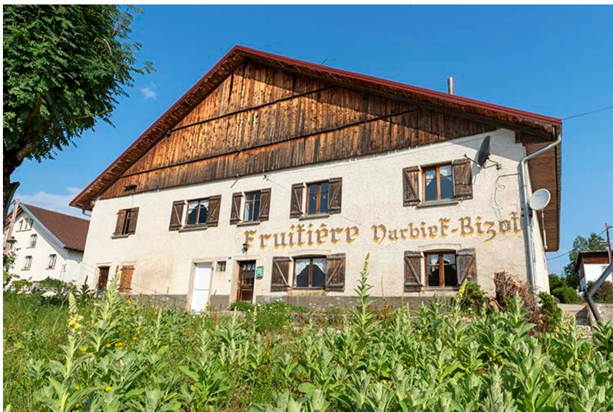
Façade antérieure, vue en contre-plongée.
