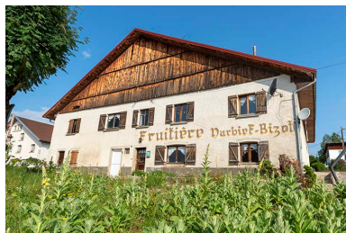
Façade antérieure, vue en contre-plongée. Phot. Sonia Dourlot IVR43_20192500691NUC4A
