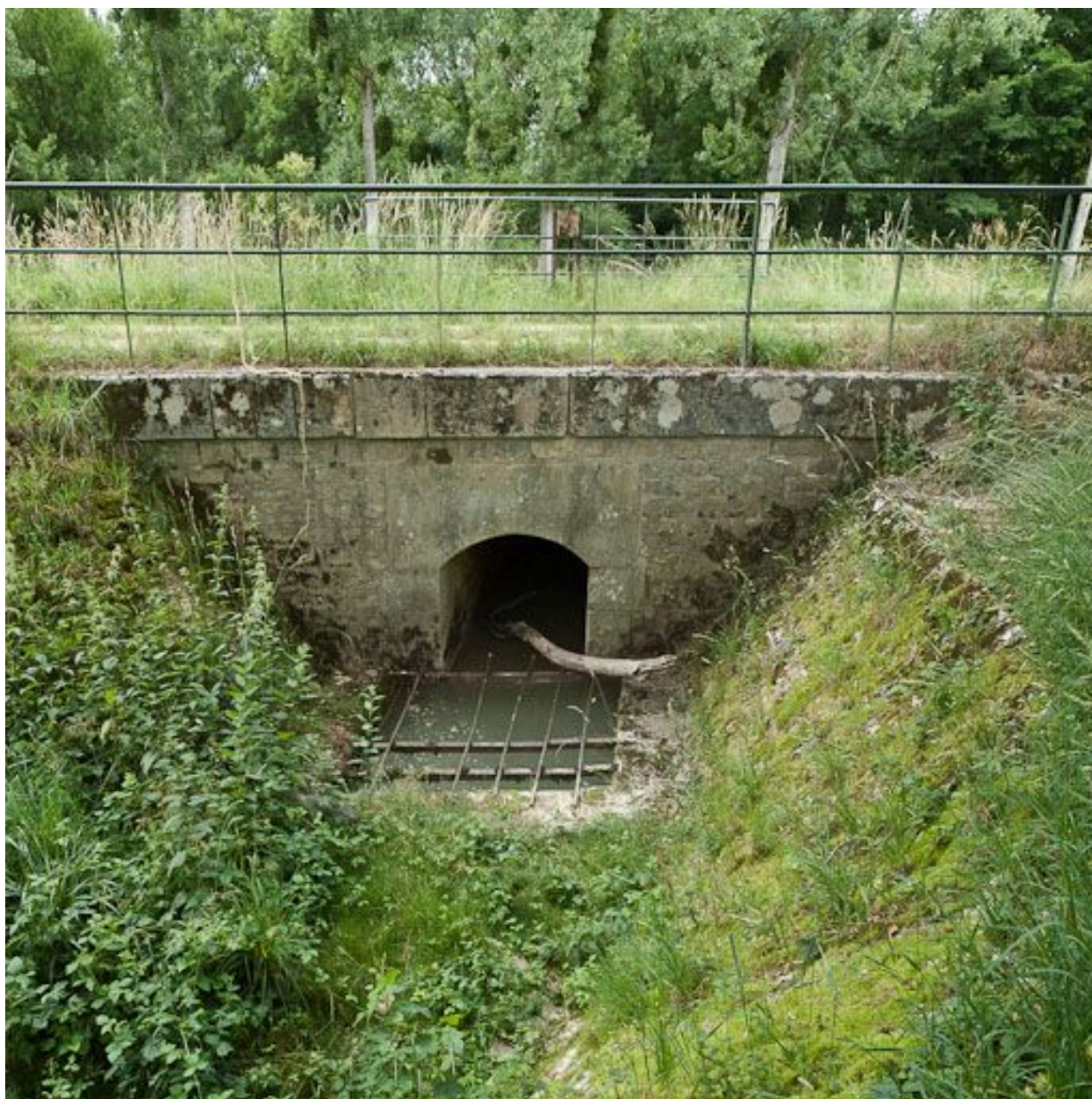
Vue de l'aqueduc.
