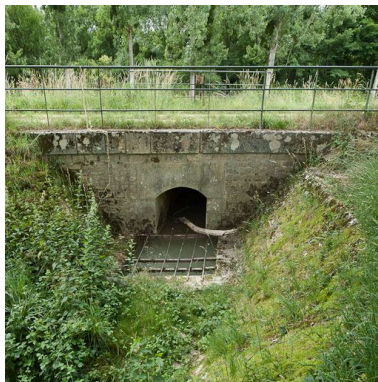
Vue de l'aqueduc. Phot. Pierre-Marie Barbe-Richaud IVR26_20112103508NUC2AQ
