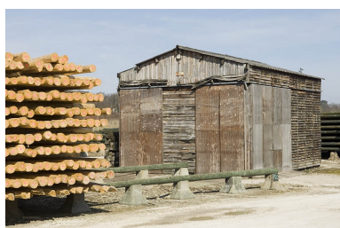
Chantier de bois et bâtiment industriel. Phot. Jérôme Mongreville IVR43_20097000121NUC2A
