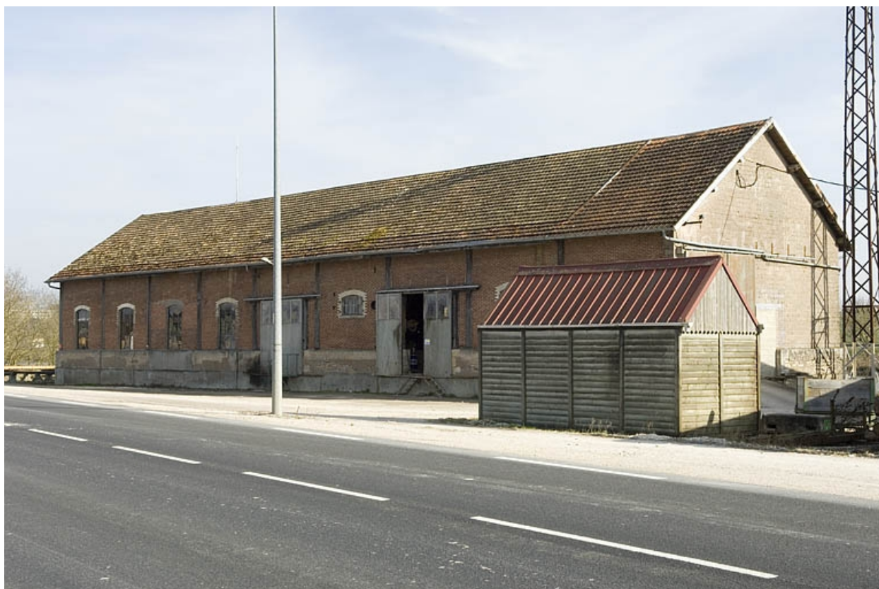
Magasin industriel depuis le nord-ouest.
