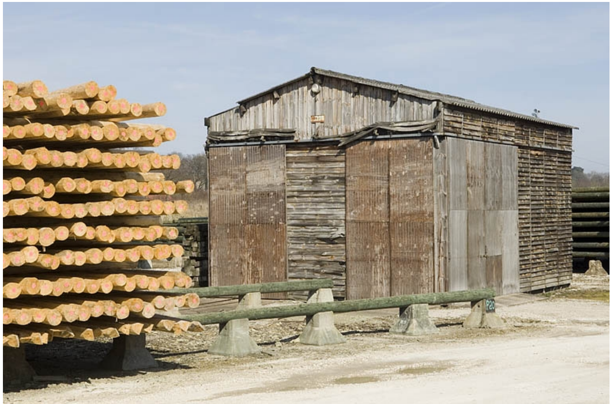
Chantier de bois et bâtiment industriel.
