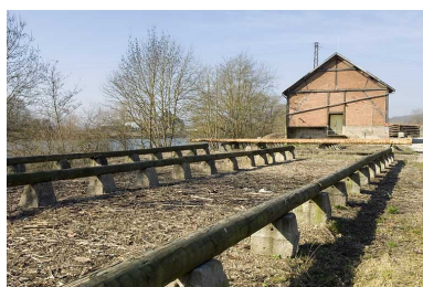
Aire de stockage et magasin industriel. Phot. Jérôme Mongreville IVR43_20097000127NUC2A
