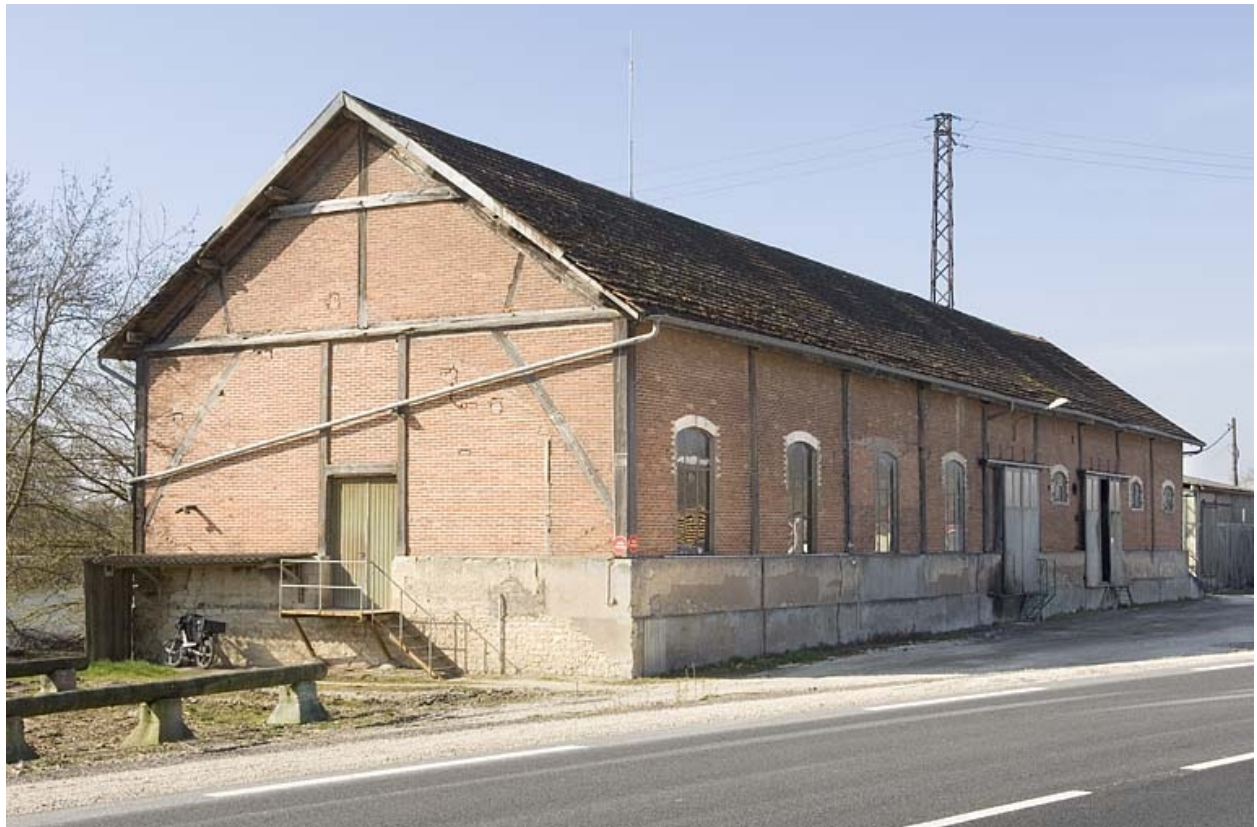
Magasin industriel depuis le nord-est.
