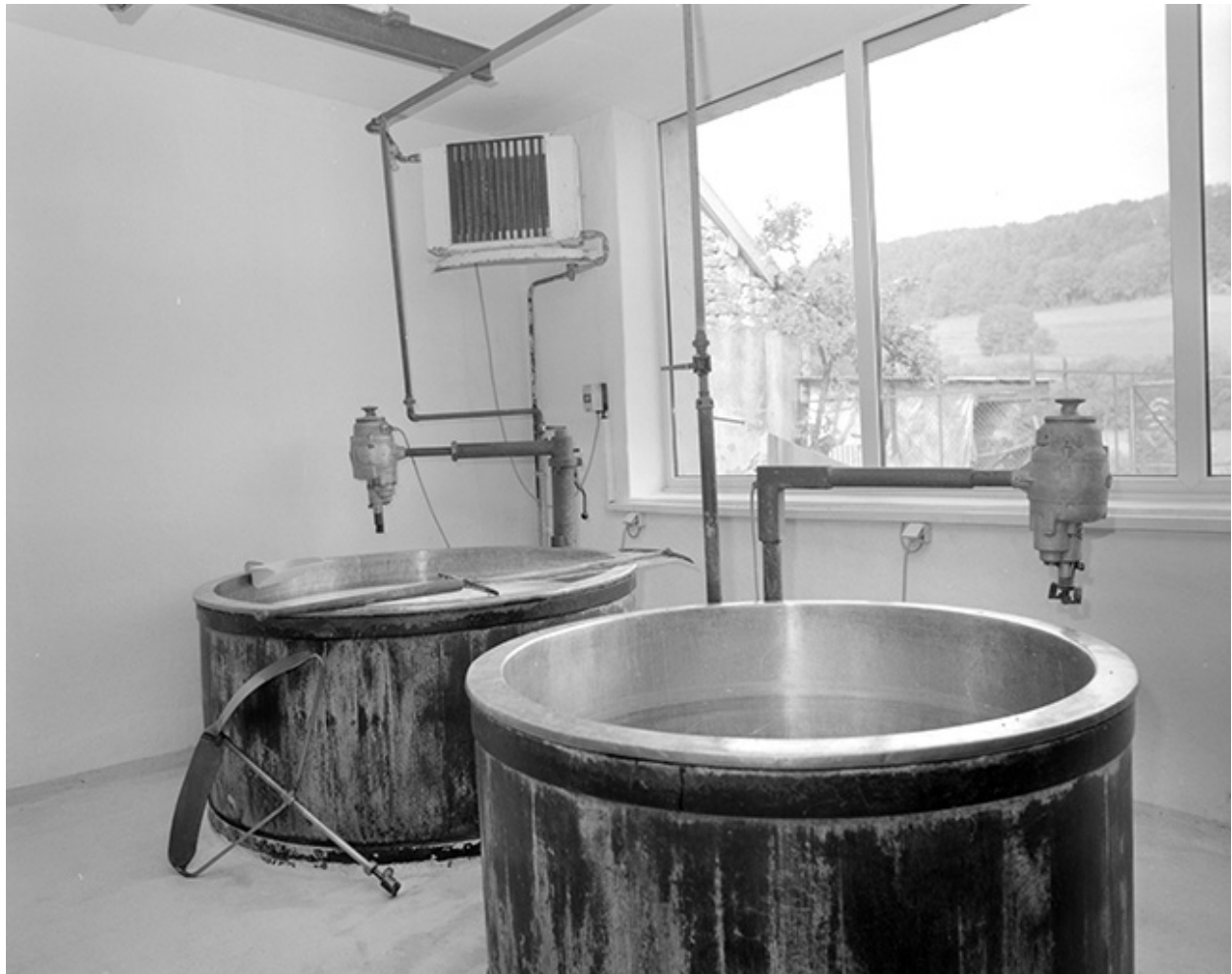
Chaudières, avec brassoir mécanique et tranche-caillé manuel.
