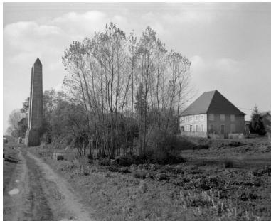
Vue d'ensemble d'une maison (cad. 1978, sect. AI, parc. 50). Phot. Michel Rosso IVR26_19867100254X
