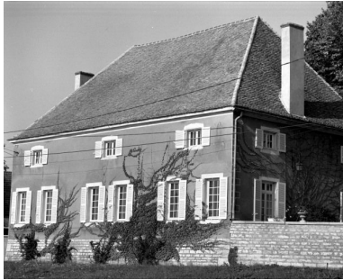
Vue d'ensemble d'une maison (cad. 1978, sect. AI, parc. 119). Phot. Michel Rosso IVR26_19867100267X
