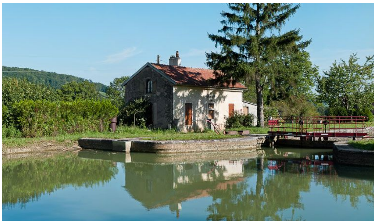
Vue du site d'écluse depuis l'amont.
