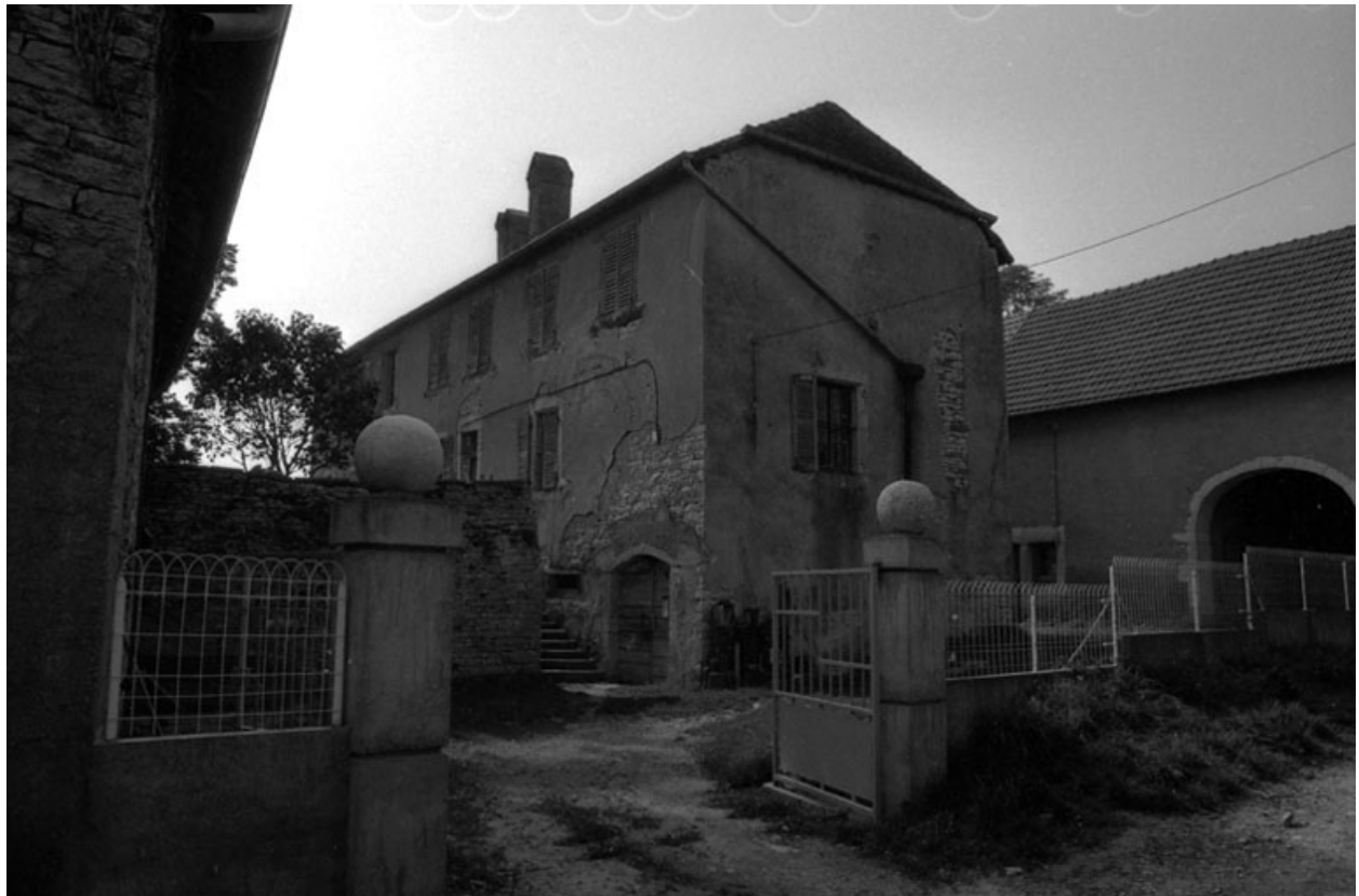
Maison d'habitation : façades antérieure et latérale droite.
