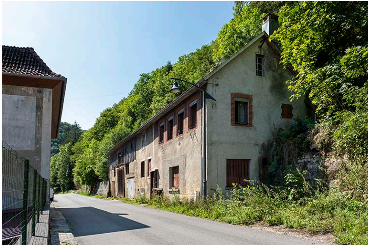
Logement occidental : vue d'ensemble, depuis le nord.
