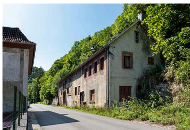
Logement occidental : vue d'ensemble, depuis le nord.
