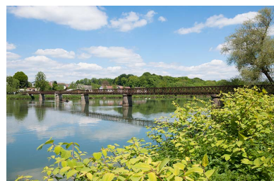
La passerelle vue depuis la rive gauche. Phot. Jérôme Mongreville IVR43_20132500456NUC4A
