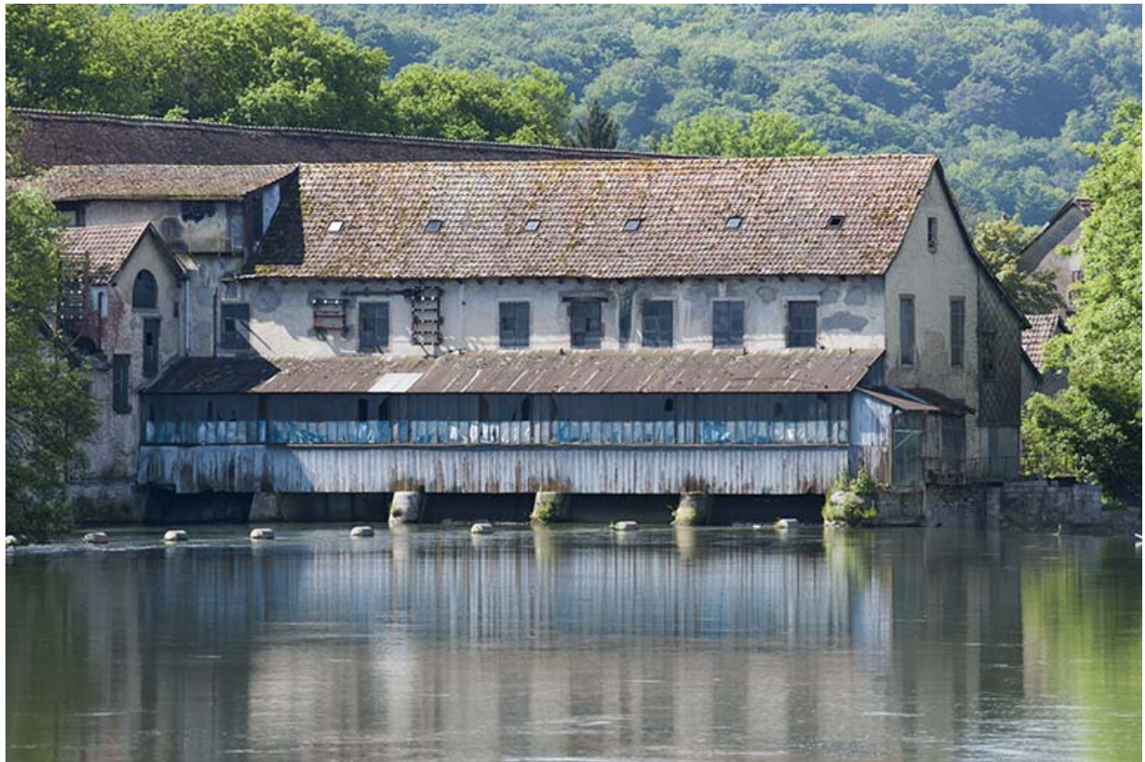
Vue rapprochée du bâtiment d'eau (centrale hydroélectrique).
