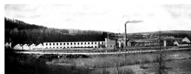
Vue d'ensemble depuis le sud- est. Photogr., s.d. [vers 1950]. Phot. Raphaël Favereaux IVR43_20122501882NUC2
