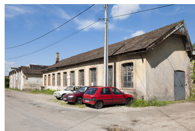
Atelier de filature. Vue de trois quarts. Phot. Jérôme Mongreville IVR43_20132500436NUC4A
