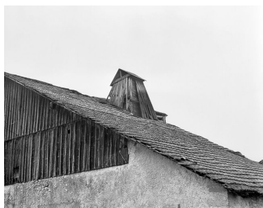
Ferme à "tué" : souche du "tué". Phot. Bernard Lardière IVR43_19782500230X
