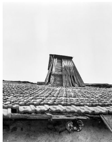
Ferme à "tué" : souche du "tué". Phot. Bernard Lardière IVR43_19782500231X
