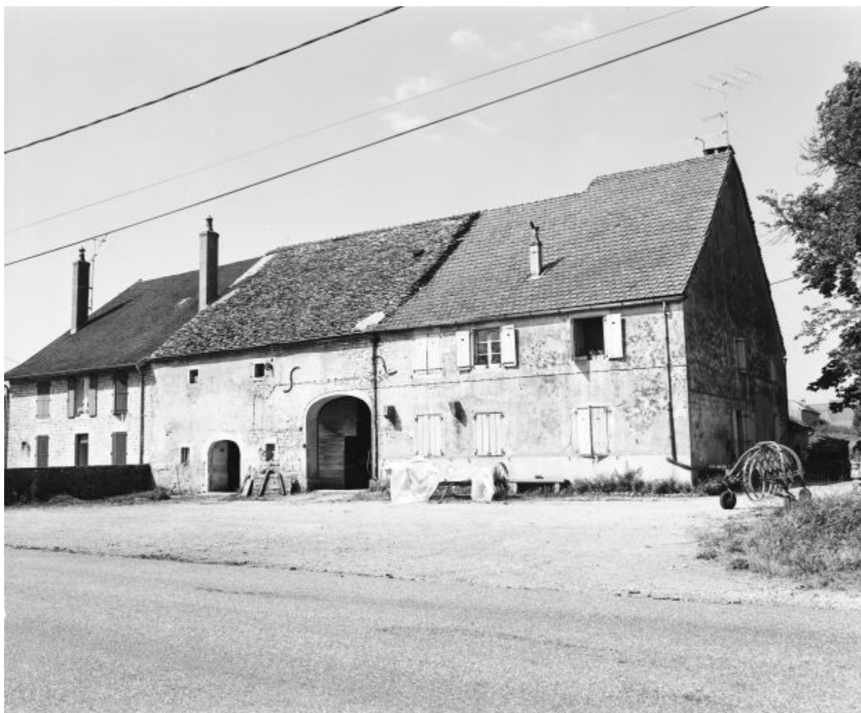
Façades antérieures de fermes.
