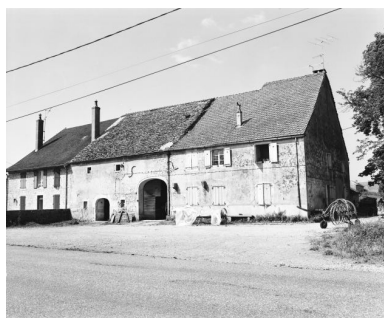
Façades antérieures de fermes.
