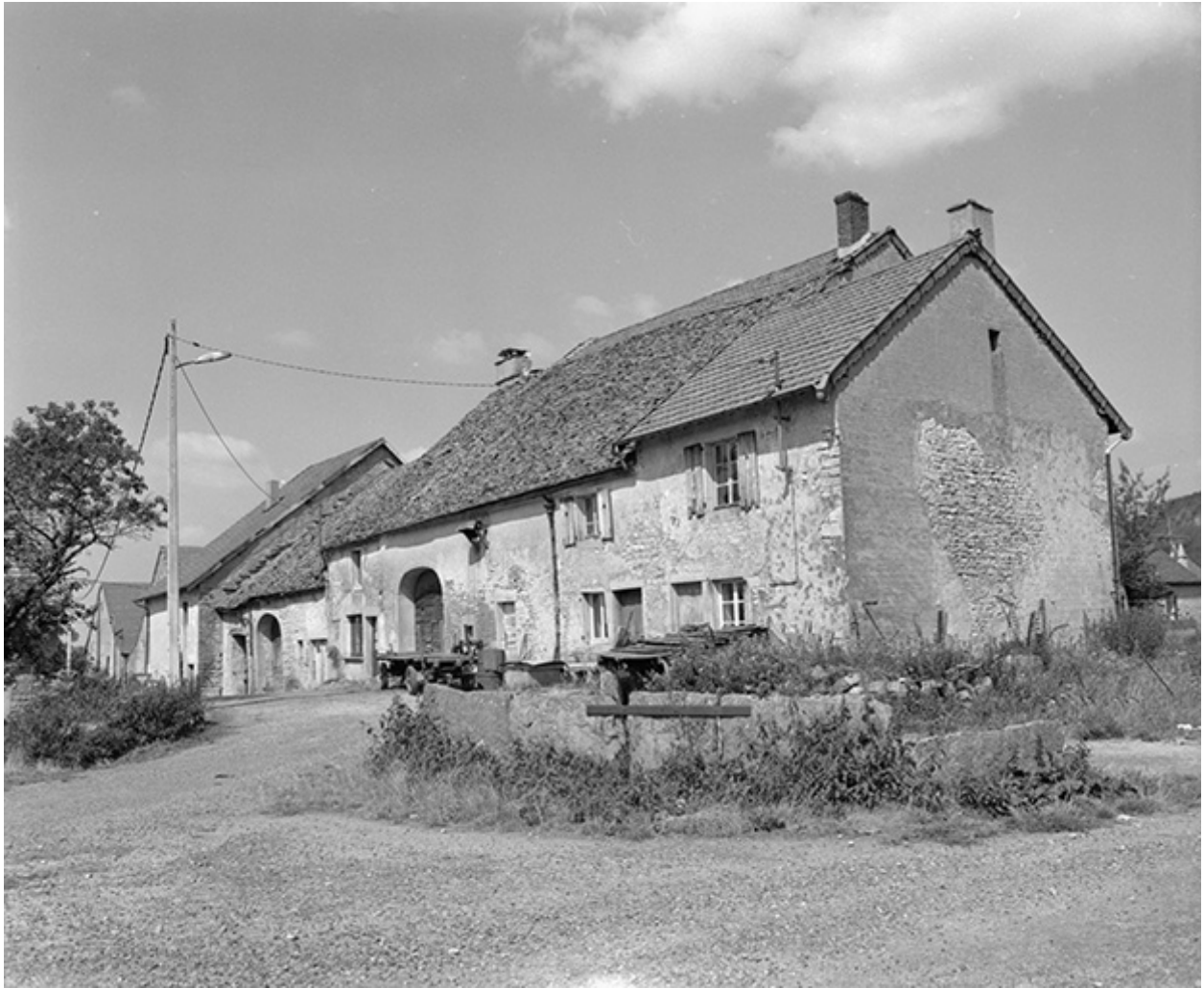
Façades antérieures de fermes.
