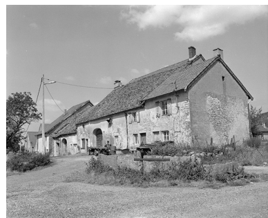
Façades antérieures de fermes. Phot. Yves Sancey IVR43_19793900124X
