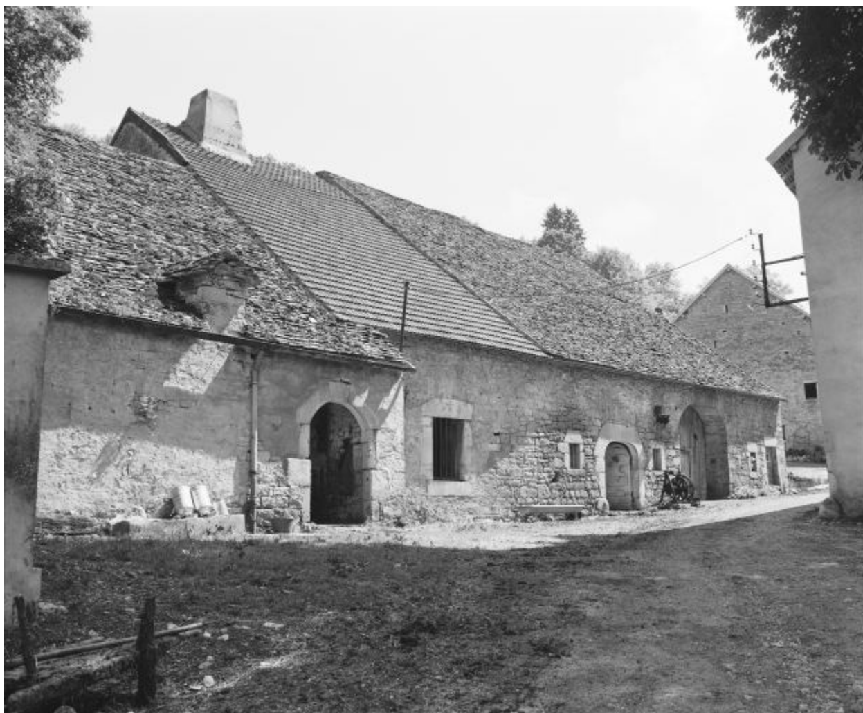
Façade antérieure de ferme.
