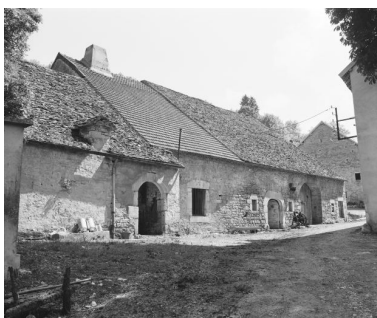
Façade antérieure de ferme.
