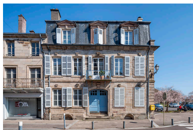
Façade sur la rue Carnot. Phot. Jérôme Mongreville IVR43_20227000118NUC4A
