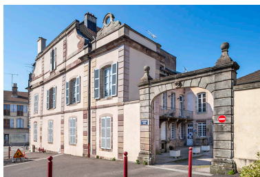
Façade sur la place du Général de Gaulle. Phot. Jérôme Mongreville IVR43_20227000121NUC4A
