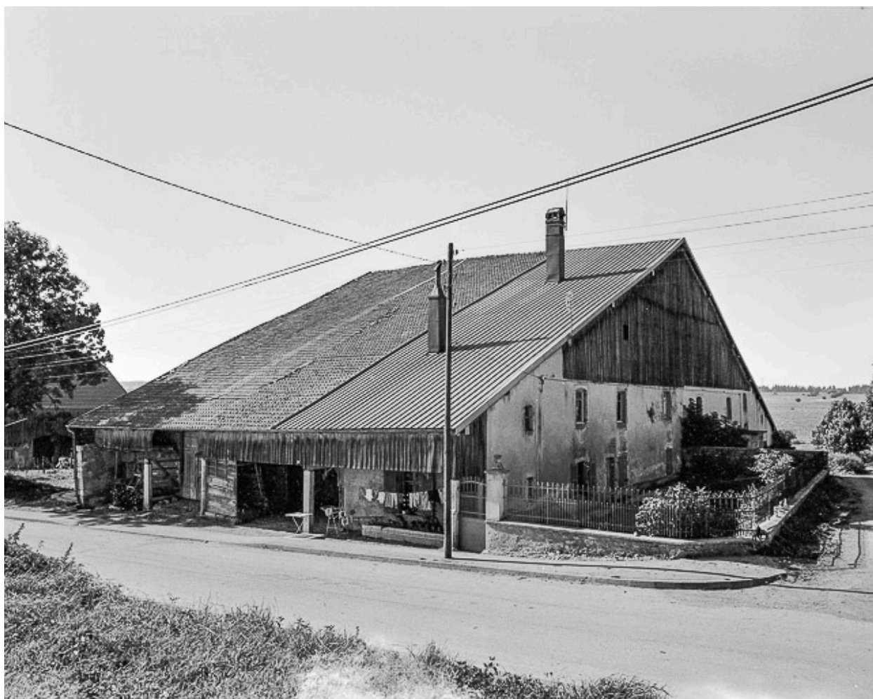
Ferme située rue Sur la Côte : vue d'ensemble.
