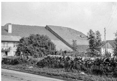
Ferme : vue de situation. Phot. Gilbert Poinot IVR43_19752501419Z
