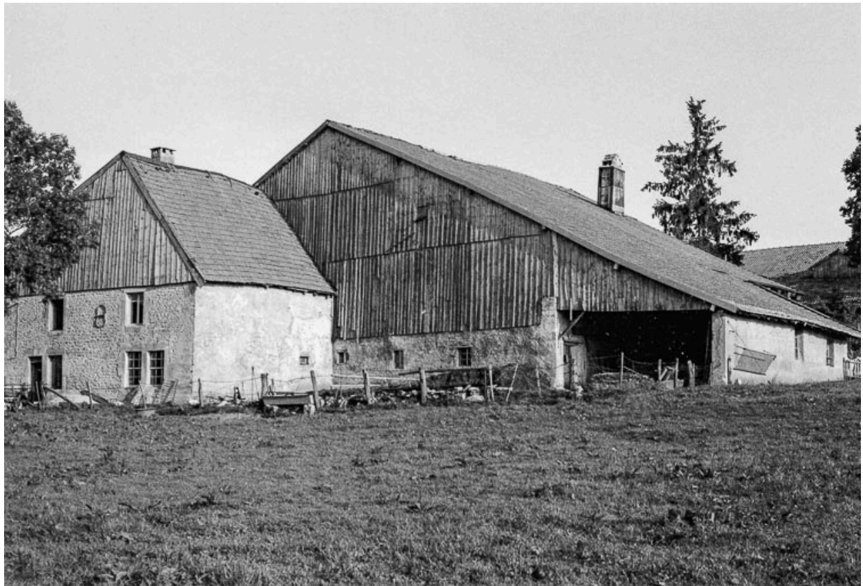
Ferme : façade antérieure.
