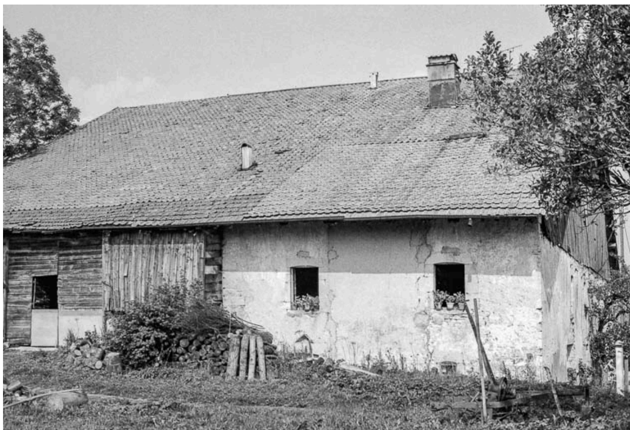
Ferme : façade postérieure.
