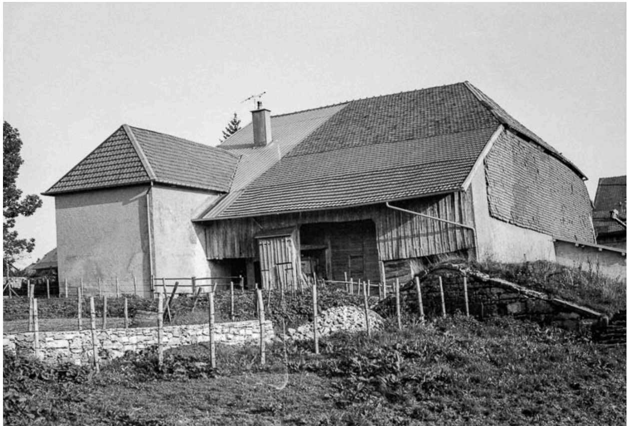
Ferme : façade postérieure.
