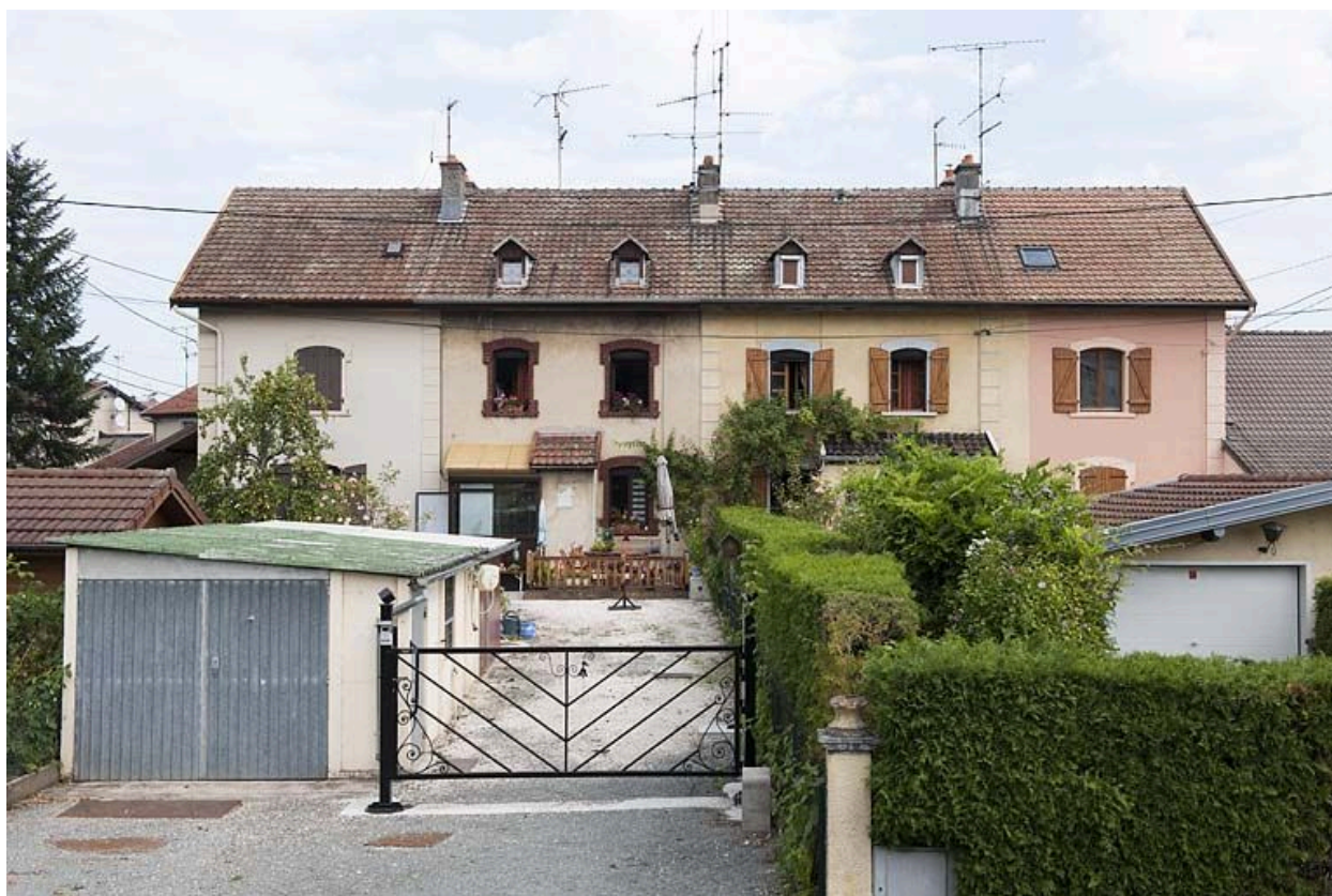
Habitation à 8 logements. Vue de face.
