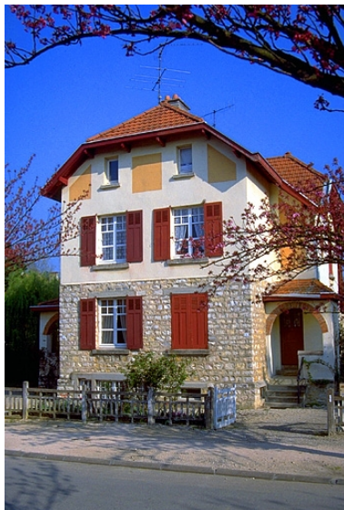
Façade antérieure. Phot. Laurent Poupard IVR43_19893900485ZA
