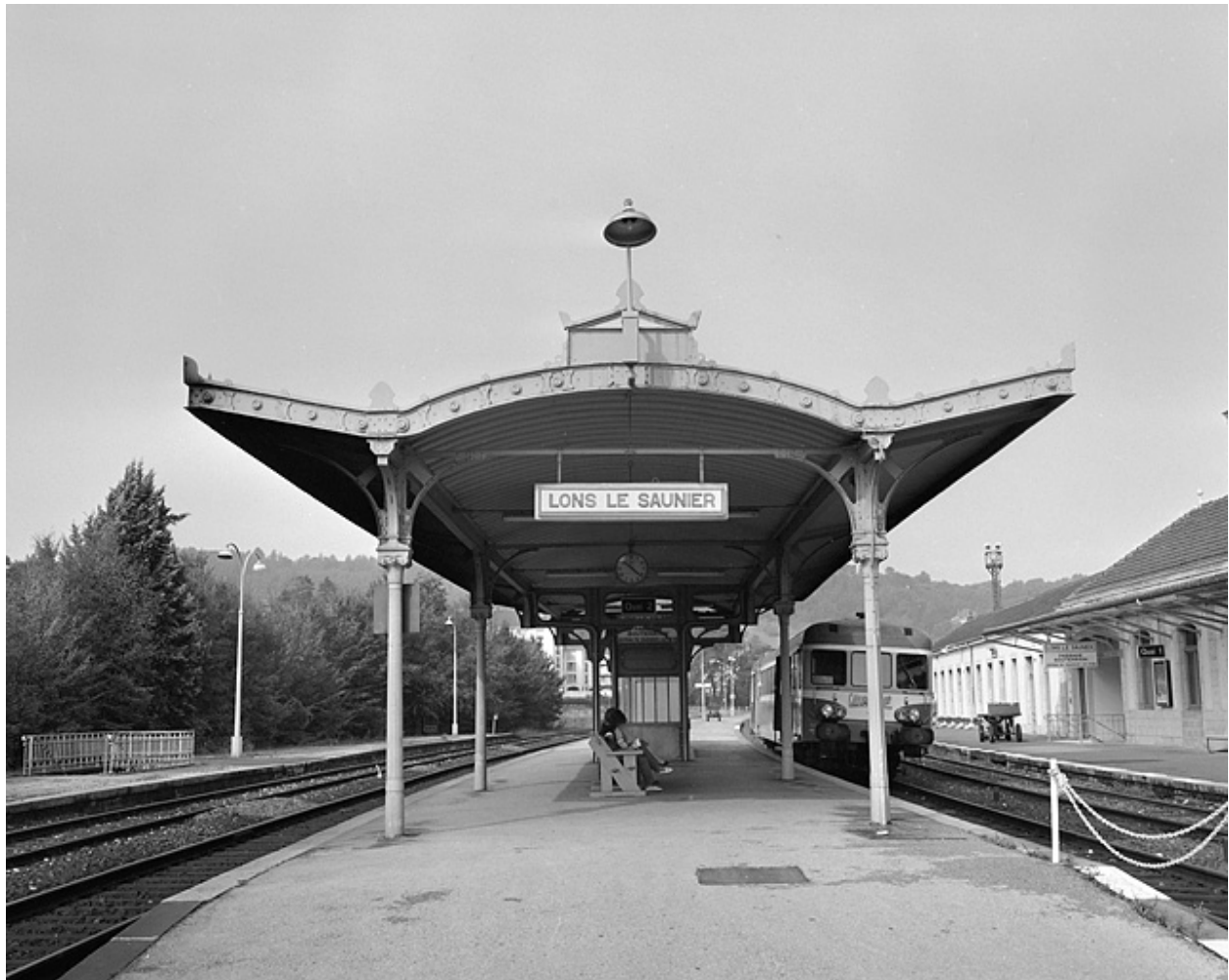
Abri métallique sur le quai.
