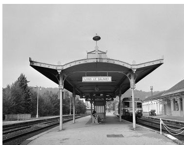
Abri métallique sur le quai. Phot. Yves Sancey IVR43_19833900110X
