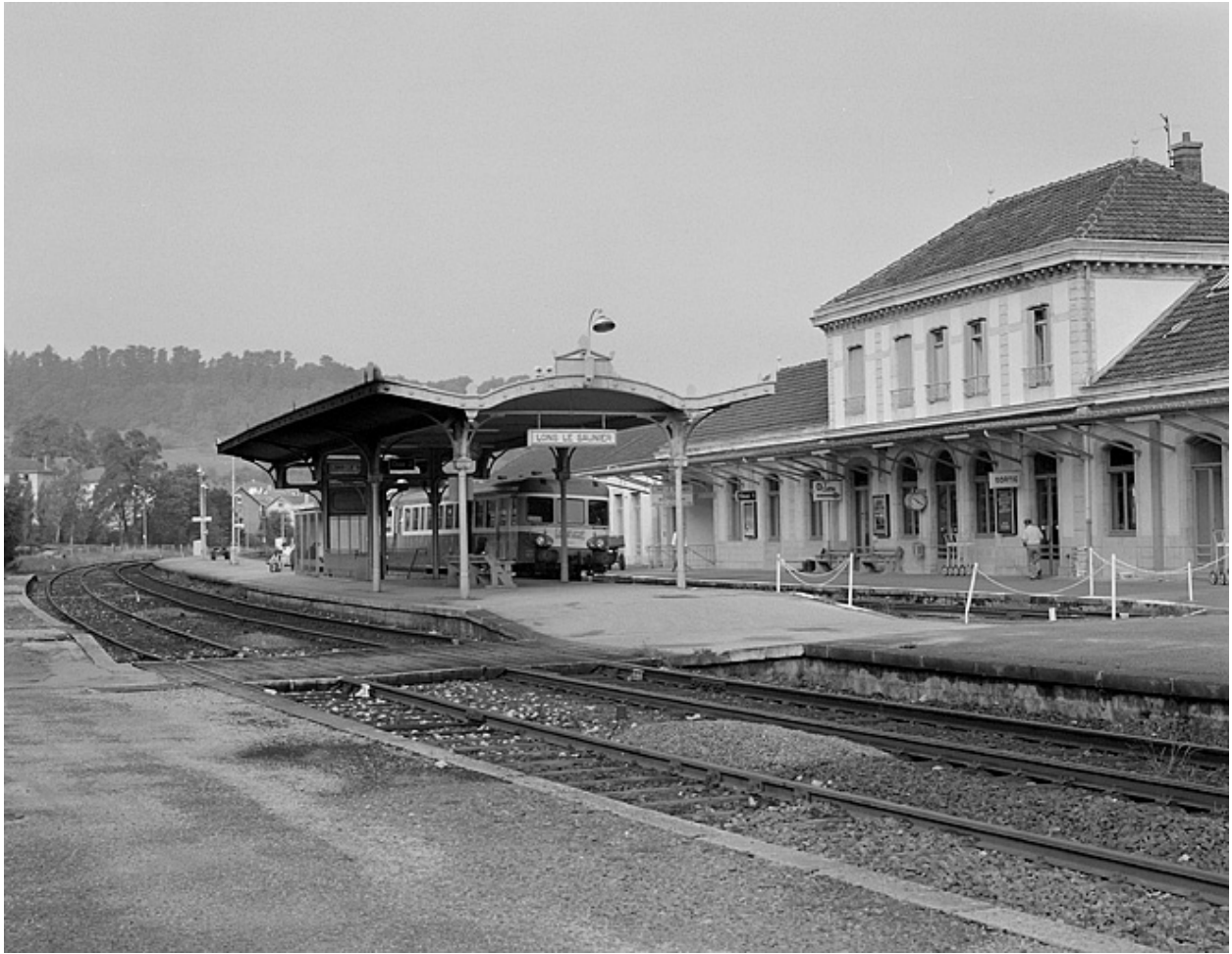
Façade postérieure et abri sur le quai.
