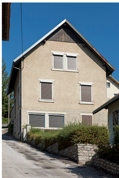
Façade latérale droite. Phot. Sonia Dourlot IVR43_20162501411NUC4A
