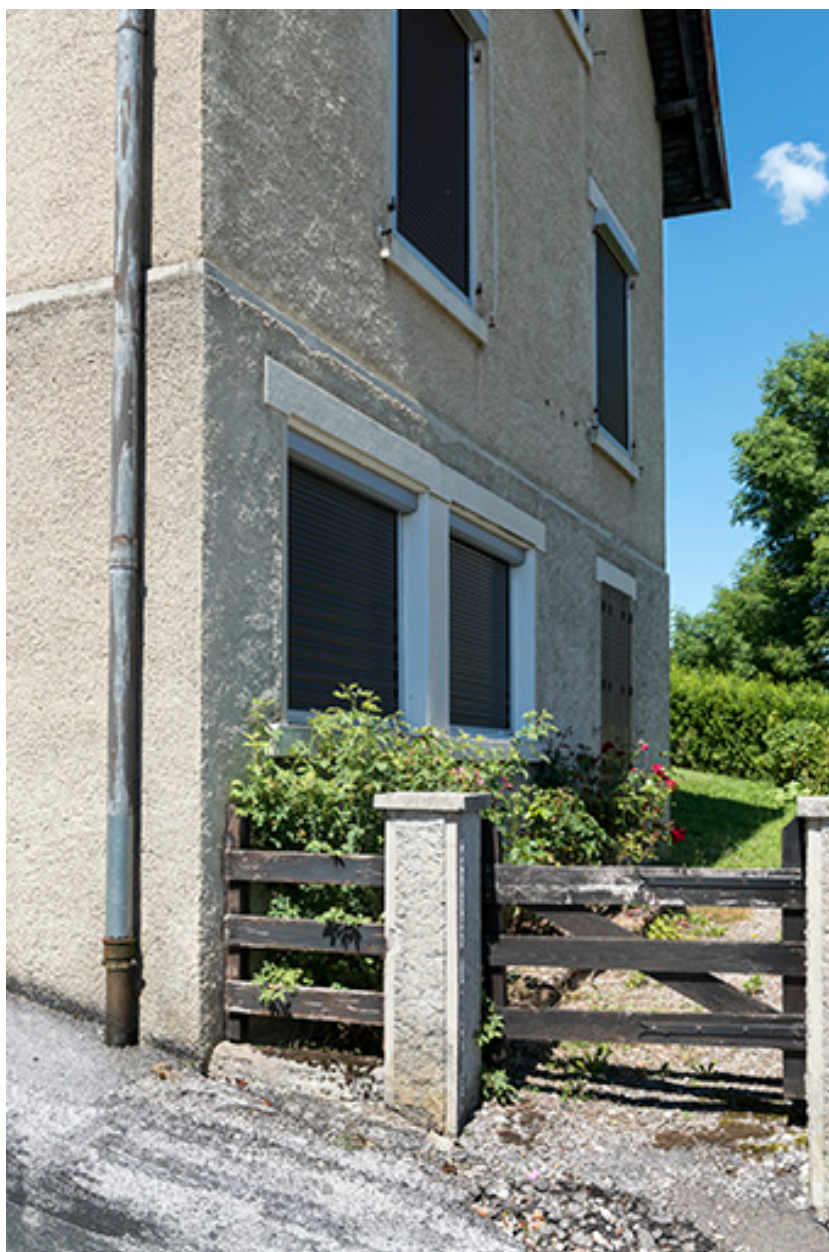
Baies d'atelier à l'étage de soubassement.
