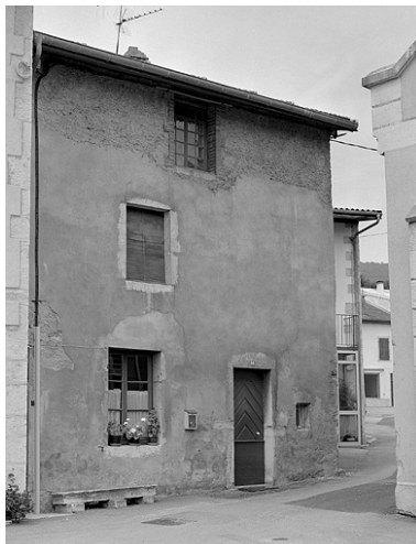
Façade antérieure. Phot. Jérôme Mongreville IVR43_19963901030X
