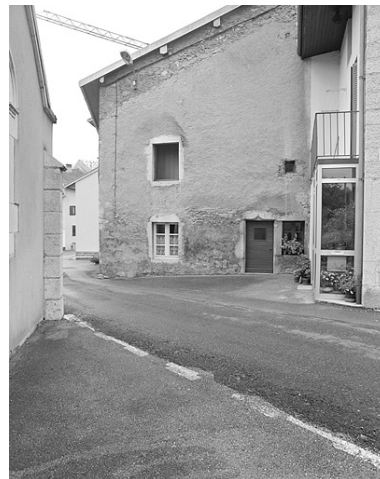
Face nord-est. Phot. Jérôme Mongreville IVR43_19963901027X
