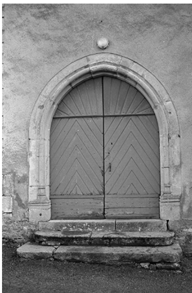
Le portail d'entrée. Phot. Guy Forestier IVR43_19743900375Z
