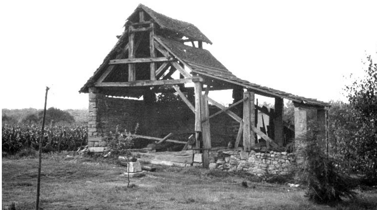
Hangar (abri du four), depuis l'est.
