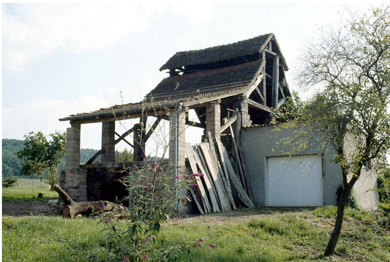
Hangar (abri du four), depuis le nord.
