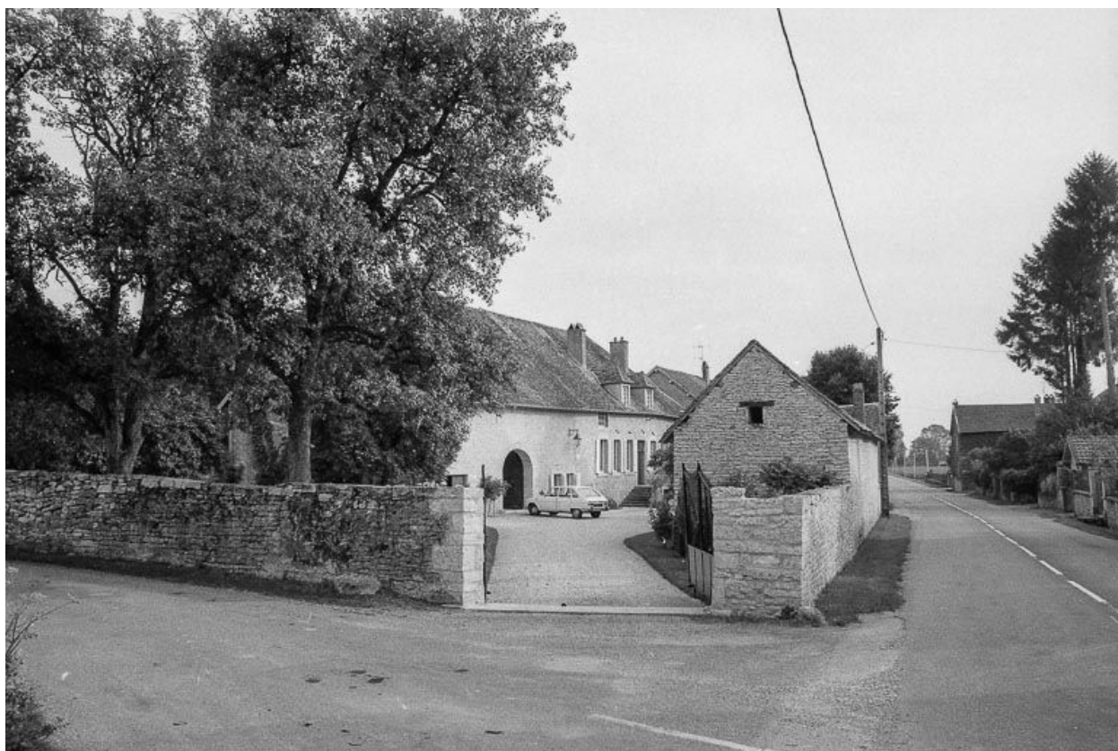
Vue d'ensemble depuis l'entrée route de Chaux.
