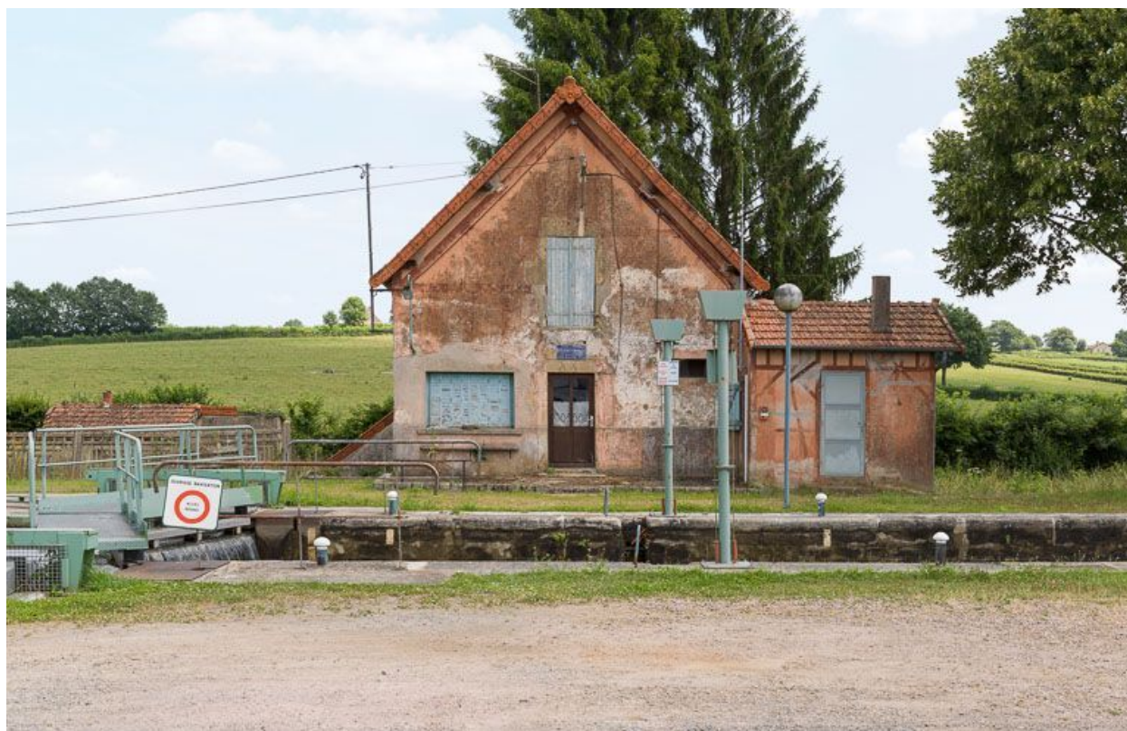
La maison éclusière de face.
