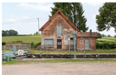
La maison éclusière de face.
