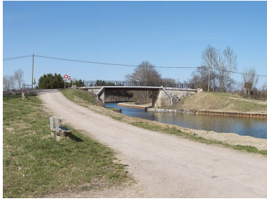
Le pont vu d'amont. Phot. Thierry Kuntz IVR26_20122102774NUC4A
