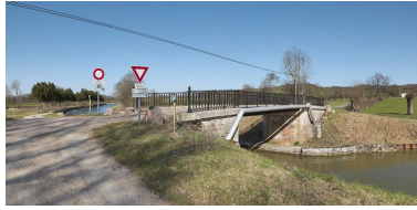
Le pont vu d'amont. Phot. Thierry Kuntz IVR26_20122102773NUC4A
