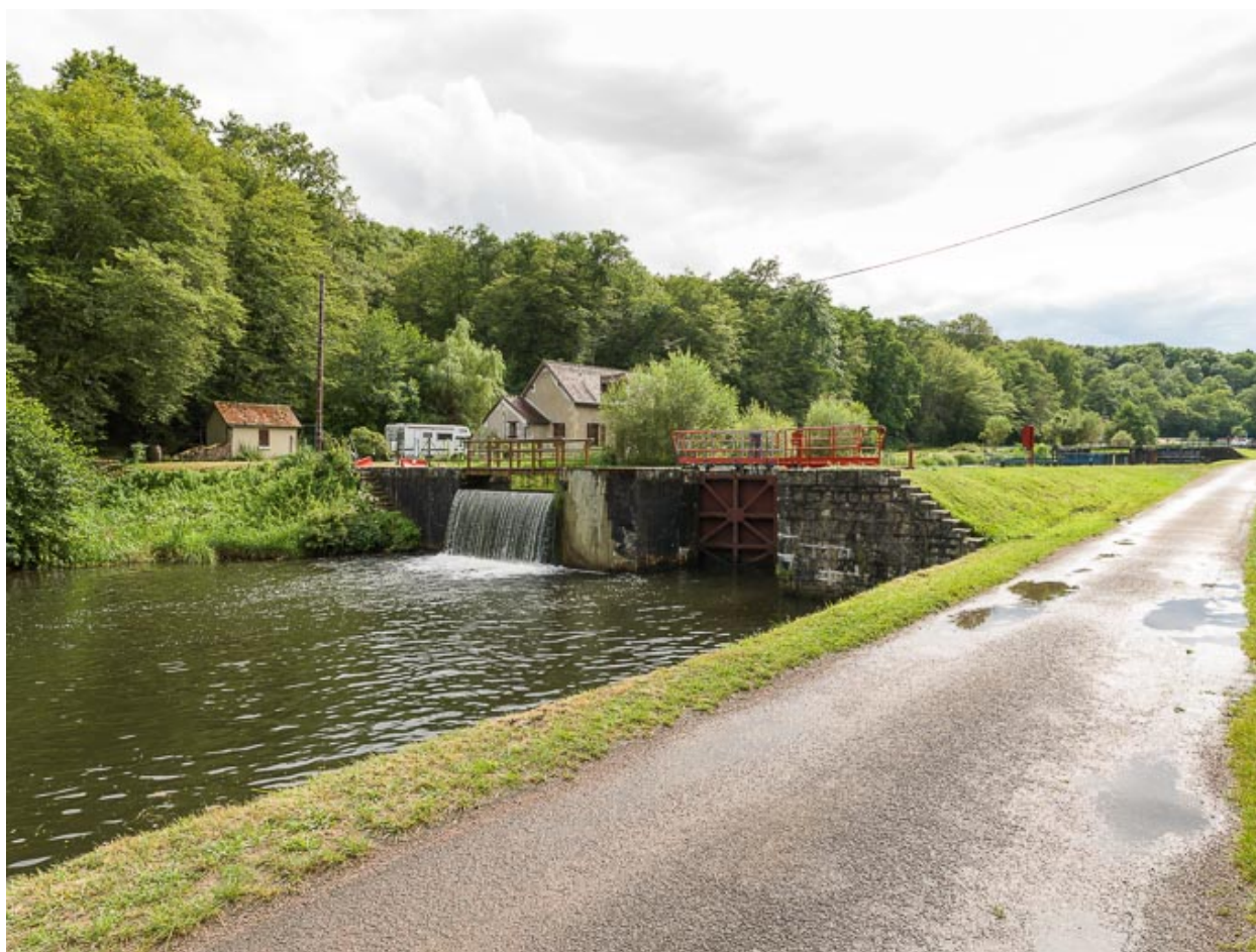
Vue du déversoir de superficie.
