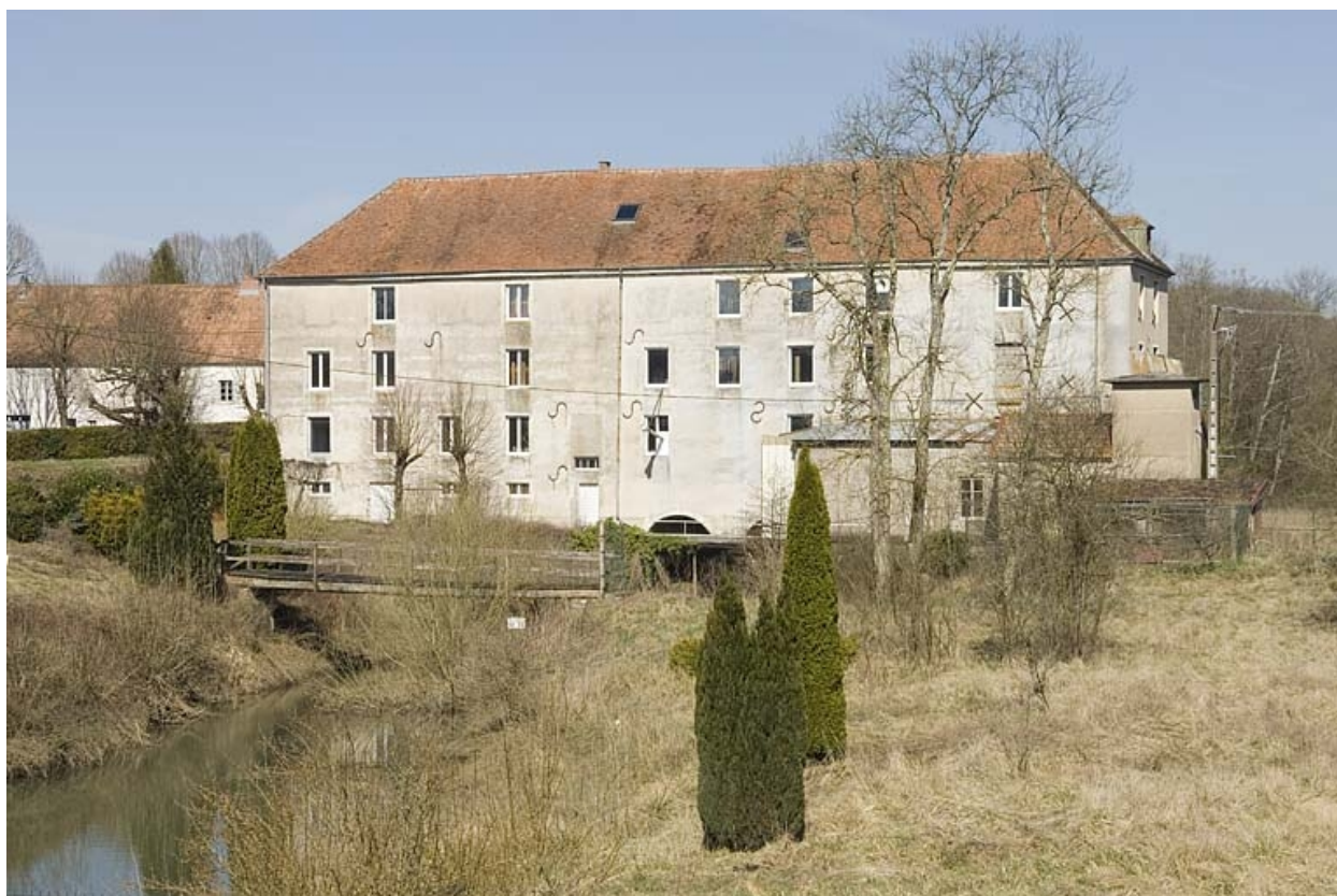
Vue d'ensemble depuis l'aval.
