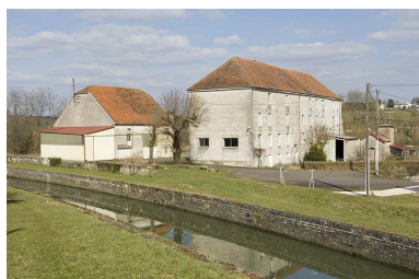
Le magasin industriel et la minoterie. Phot. Jérôme Mongreville IVR43_20097000258NUC2A
