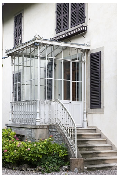
Escalier sur la façade est. Phot. Jérôme Mongreville IVR43_20112501569NUC4A
