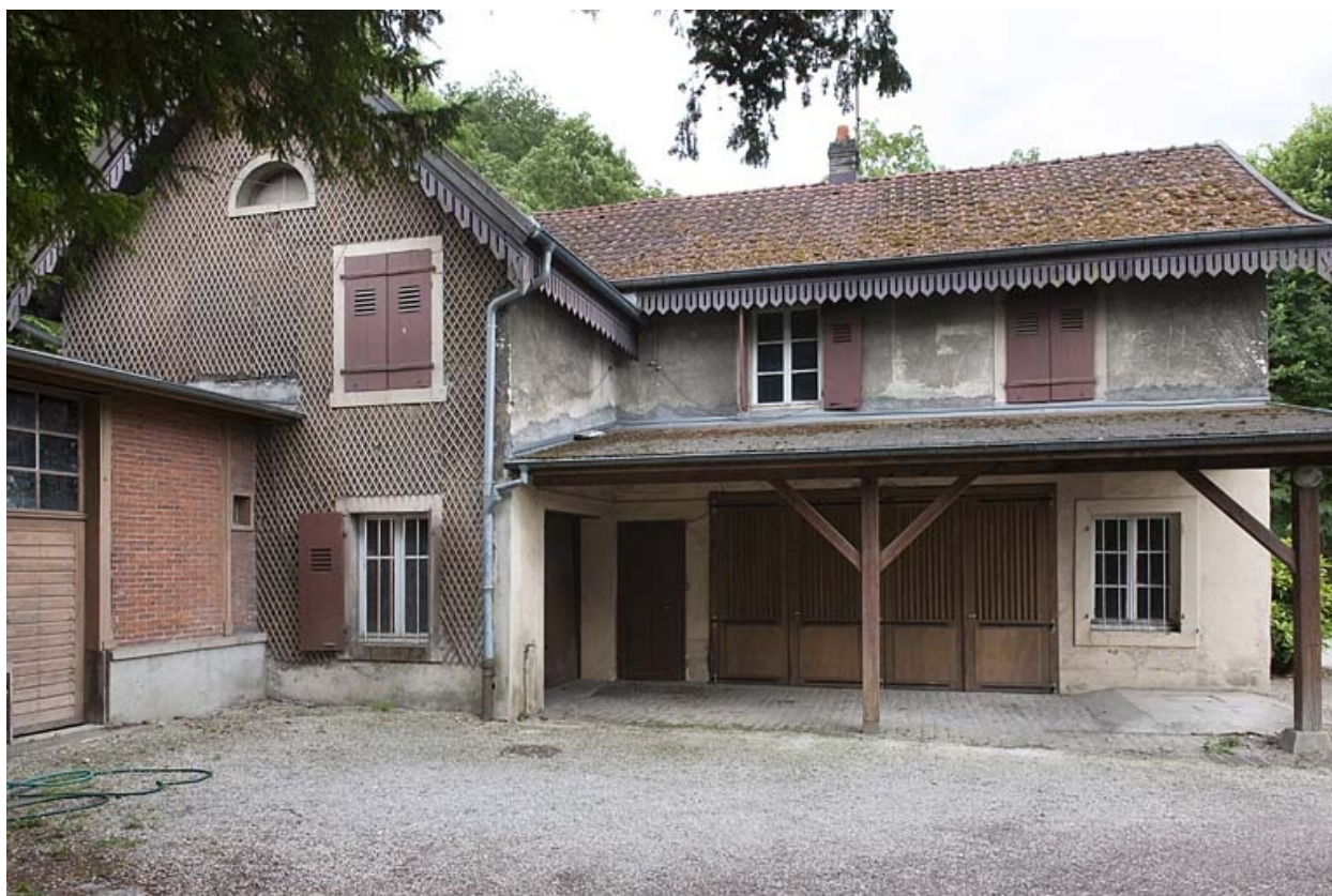
Façade nord des communs.
