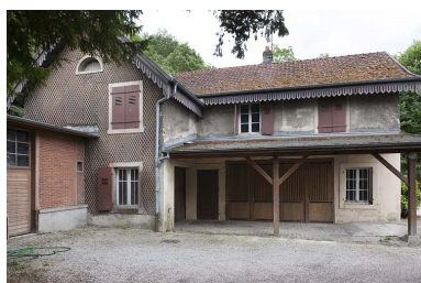
Façade nord des communs. Phot. Jérôme Mongreville IVR43_20112501577NUC4A
