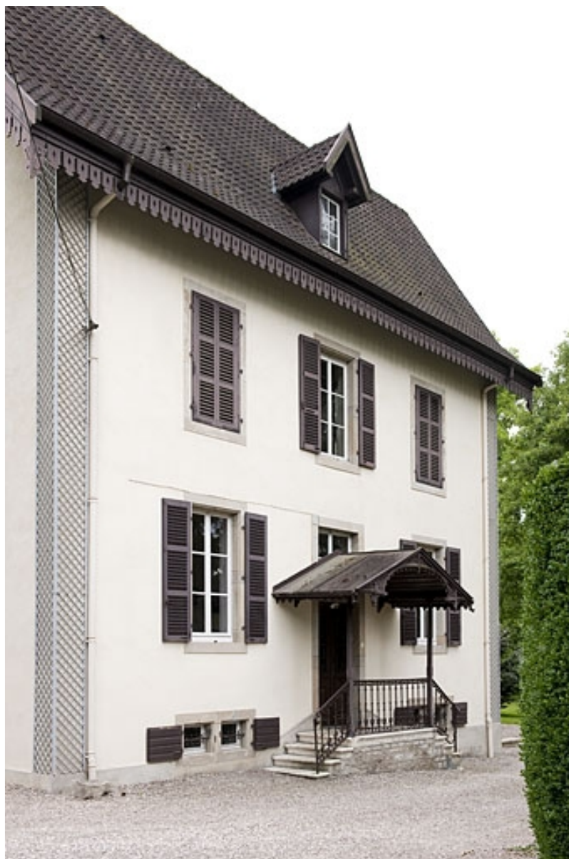
Façade nord vue de trois quarts.
