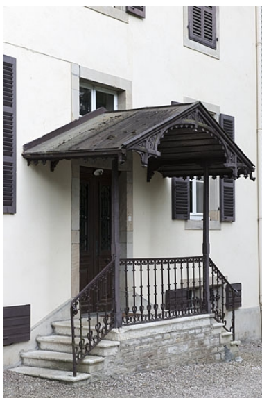
Entrée de la façade nord. Phot. Jérôme Mongreville IVR43_20112501570NUC4A
