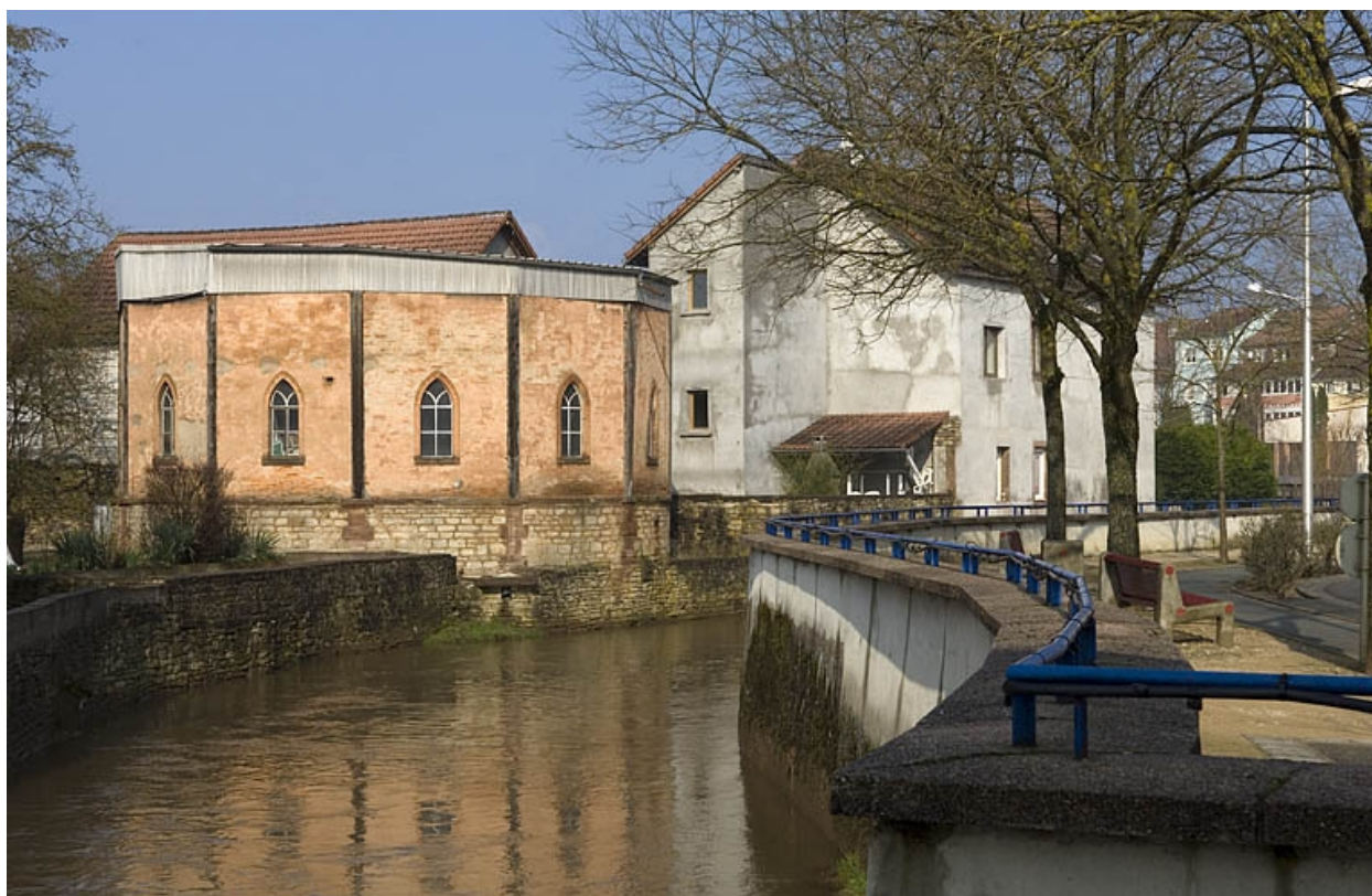
Vue d'ensemble en aval de la Lizaine.
