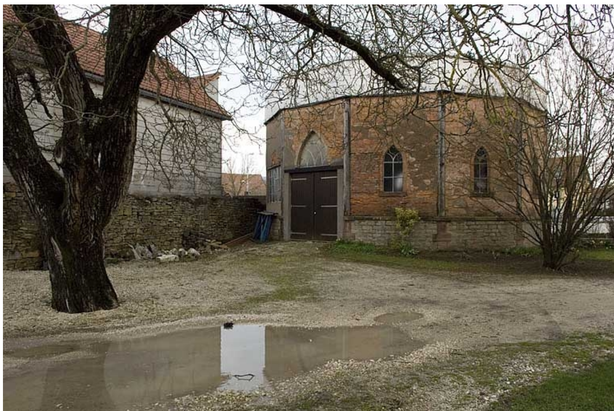
Vue depuis l'entrée.
