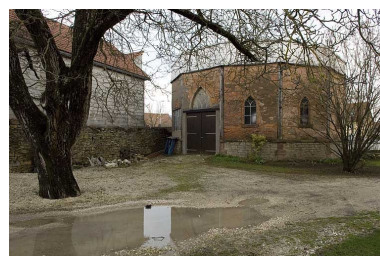
Vue depuis l'entrée. Phot. Jérôme Mongreville IVR43_20067000118NUCA
