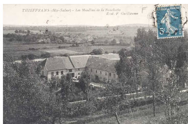
Thieffrans (Haute-Saône). - Les Moulins de la Rouchotte. Phot. Jérôme Mongreville IVR43_20097000023NUC2A
