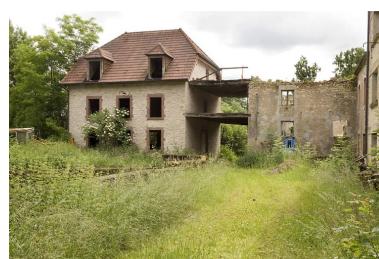
Logement et bâtiment en ruine. Phot. Jérôme Mongreville IVR43_20087000592NUC2A
