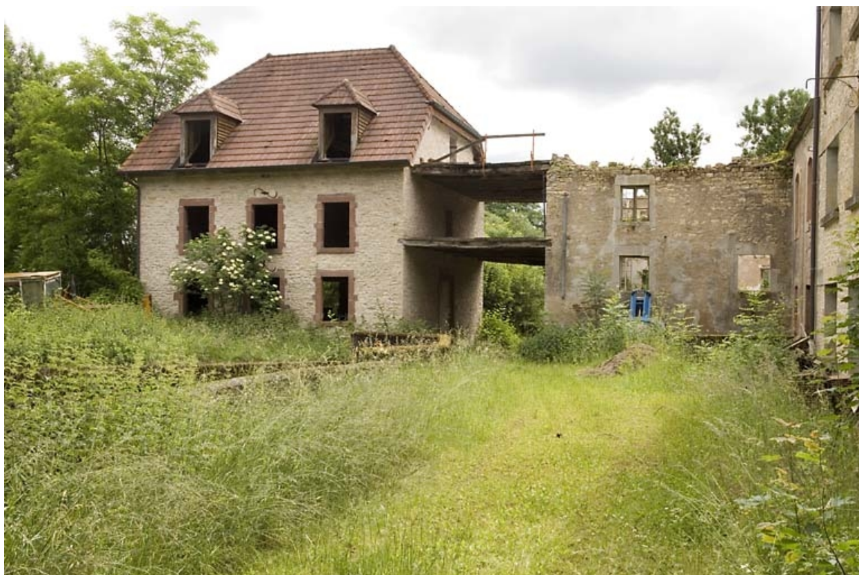
Logement et bâtiment en ruine.
