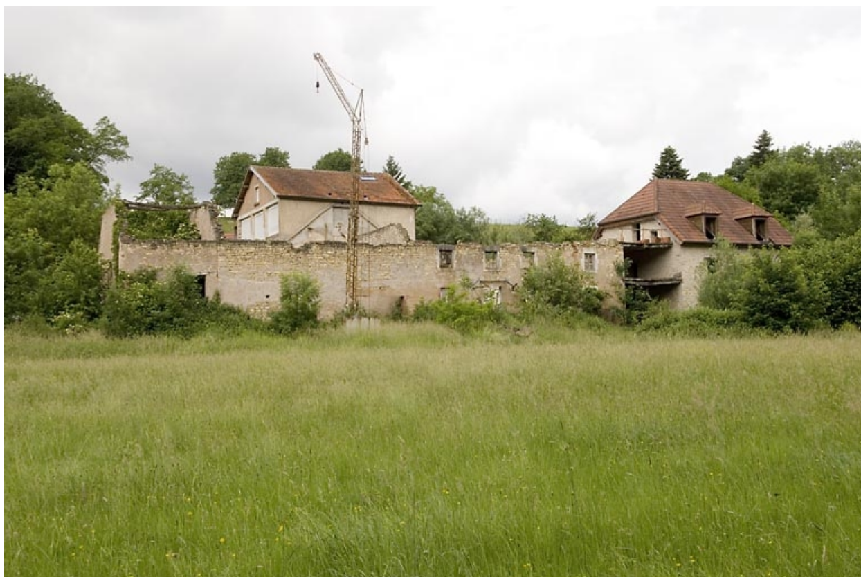
Bâtiment en ruine depuis l'est.
