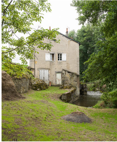
Vue du moulin. Phot. Pierre-Marie Barbe-Richaud IVR26_20175800316NUC2A
