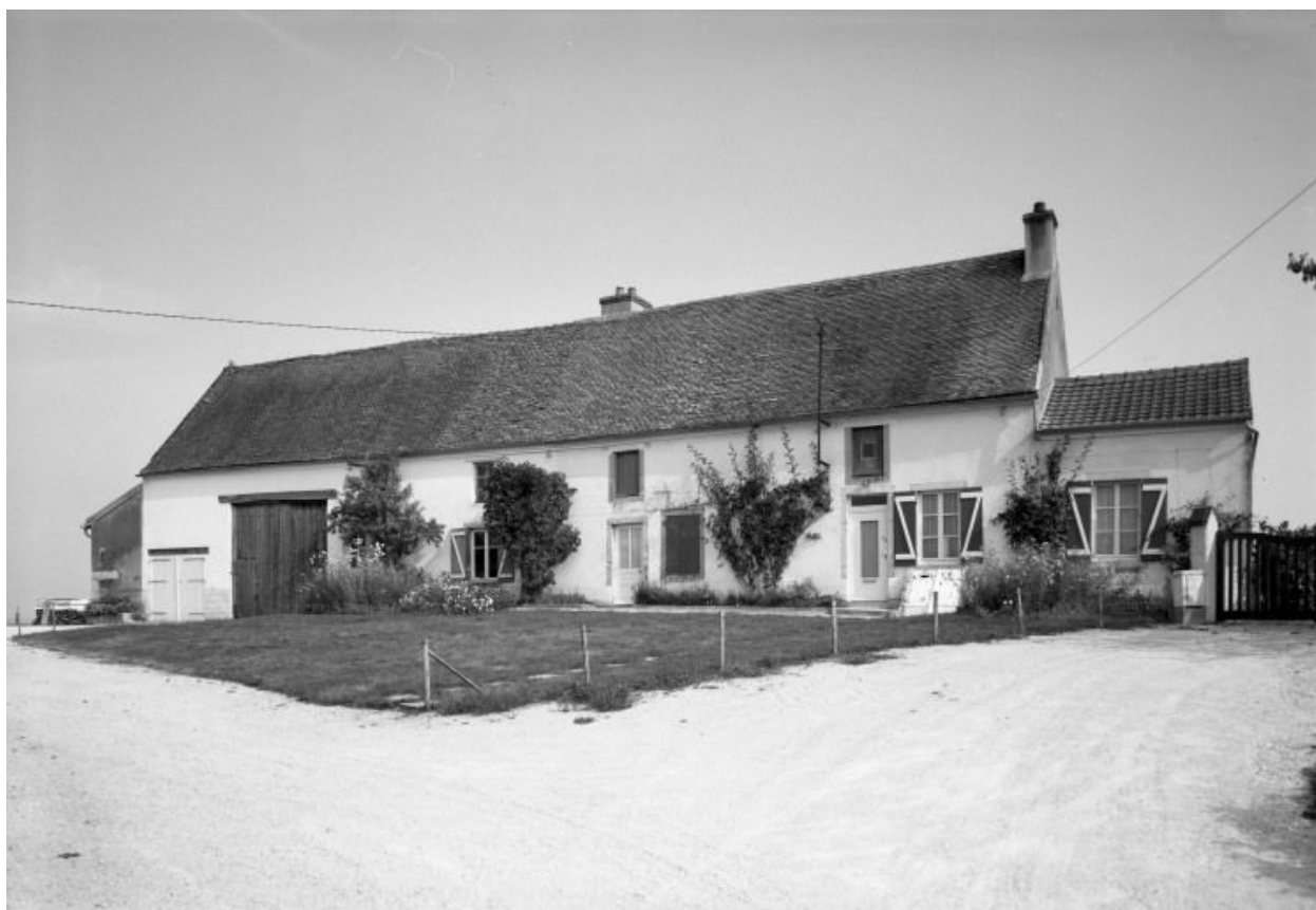
Vue d'ensemble d'une ferme (cad. 1973, sect. AC, parc. 20-21).
