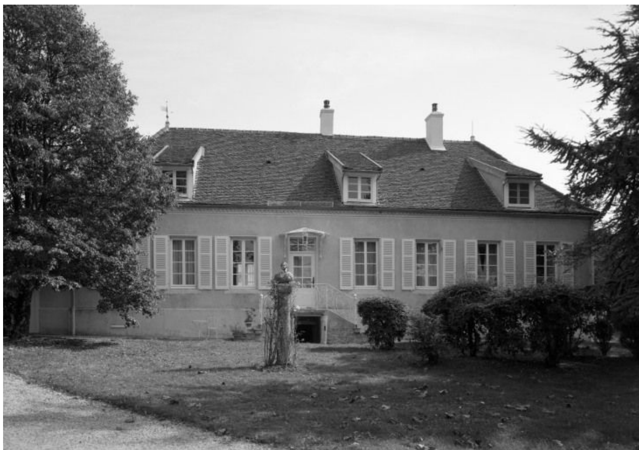
Vue d'ensemble d'une maison (cad. 1973, sect. AC, parc. 46).
