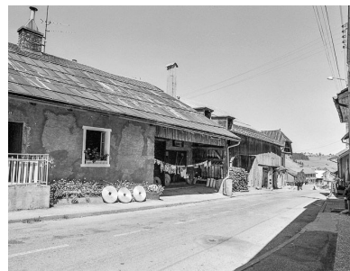
Fermes situées rue Saint-Jean. Phot. Dominique Dominguez IVR43_19792501033X
