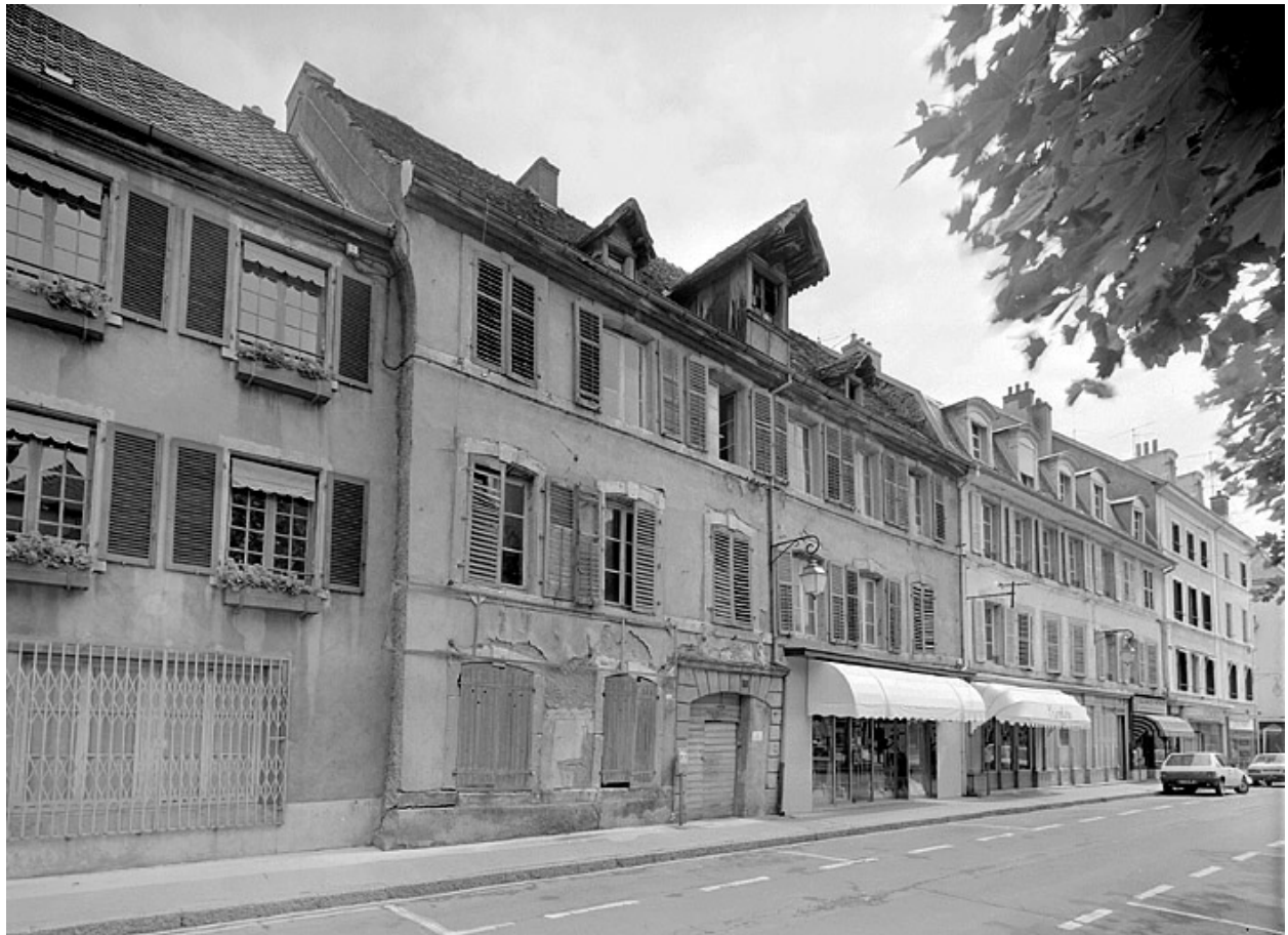
Façade principale sur la place Dorian.
