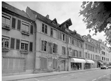
Façade principale sur la place Dorian.
