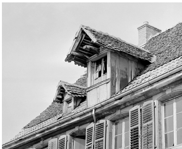
Façade principale sur la place Dorian.
