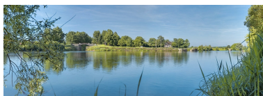
Vue d'ensemble de l'entrée de la dérivation, à hauteur du barrage. À gauche, la porte de garde et le pont l'enjambant. Phot. Thierry Kuntz IVR26_20172100222NUC4A
