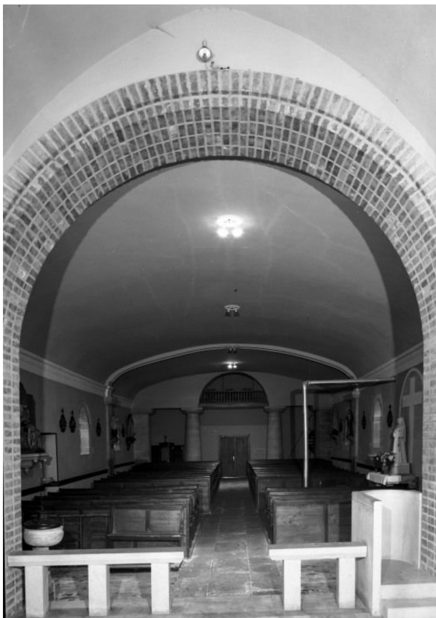
Vue de la nef prise du choeur
