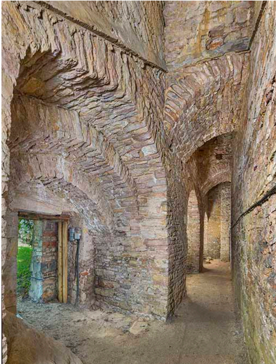
Poterne d'accès à la galerie.
