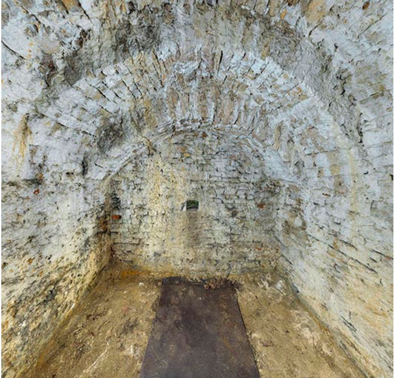
Une casemate de la contremine.
