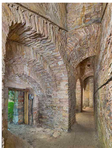
Poterne d'accès à la galerie.
