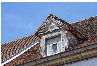
La lucarne ancienne. Phot. Jérôme Mongreville IVR43_20217000380NUC4A
