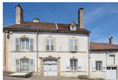
L'ensemble vu de face. Phot. Jérôme Mongreville IVR43_20217000378NUC4A
