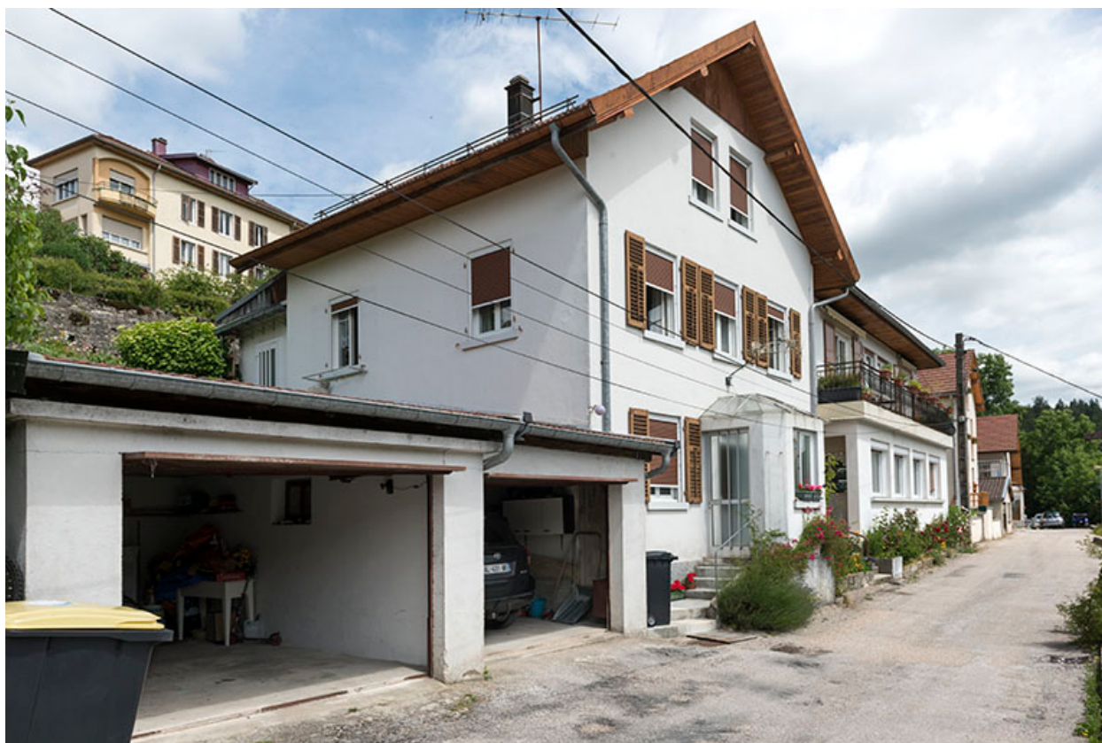
Façades antérieure et latérale gauche.
