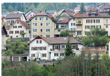
Vue d'ensemble éloignée, depuis l'est. Phot. Sonia Dourlot IVR43_20162500644NUC4A
