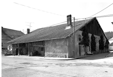
Ferme située 37 Grande Rue : vue de trois quarts gauche. Phot. Bernard Lardière IVR43_19782500327X
