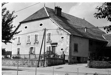
Ferme située 35 Grande Rue : vue de trois quarts droit. Phot. Gilbert Poinot IVR43_19752501243Z
