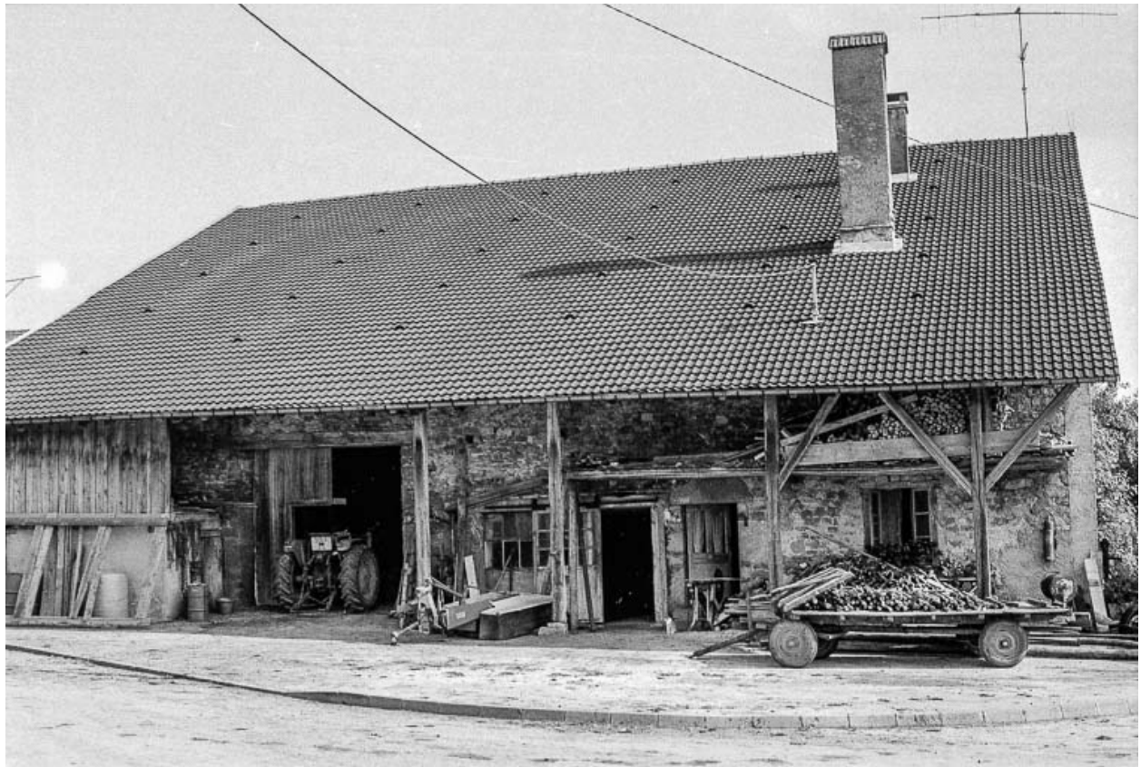
Ferme située rue du Mont : façade antérieure.
