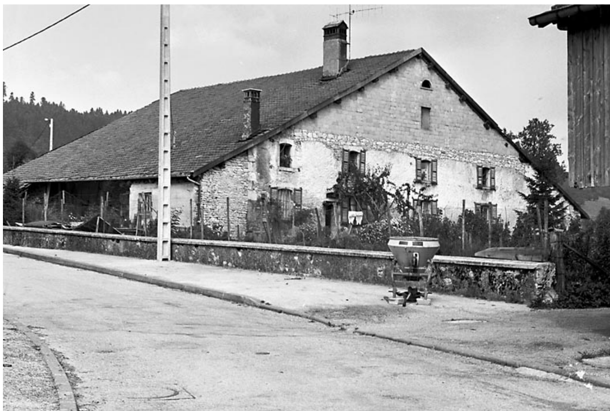
Ferme située rue de l'Eglise : vue de trois quarts gauche.
