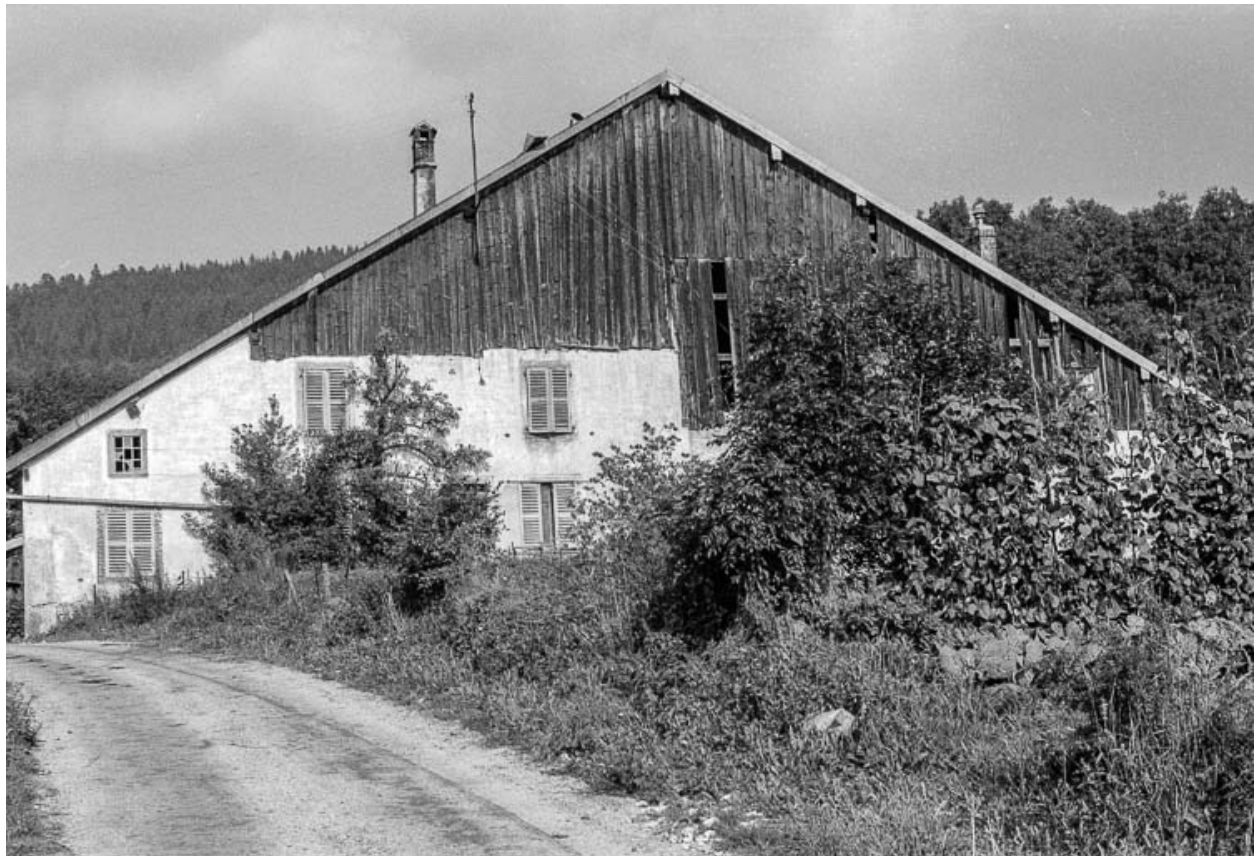
Ferme : vue d'ensemble depuis le chemin.
