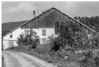
Ferme : vue d'ensemble depuis le chemin. Phot. Gilbert Poinot IVR43_19752501267Z
