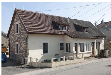
Maison jumelée. Phot. Jérôme Mongreville IVR43_20122500215NUC4A
