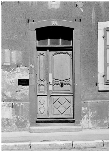
Porte d'entrée. Phot. Jérôme Mongreville IVR43_19872500528X
