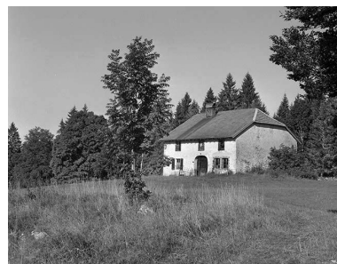
Ferme située au lieudit La Combe de Morbier. Phot. Jérôme Mongreville IVR43_20003900458X
