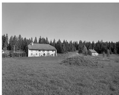
Ferme située au lieudit La Combe de Morbier. Phot. Jérôme Mongreville IVR43_20003900474X
