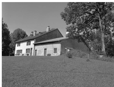
Ferme située au lieudit Les Petits Valets. Phot. Jérôme Mongreville IVR43_20003900434X
