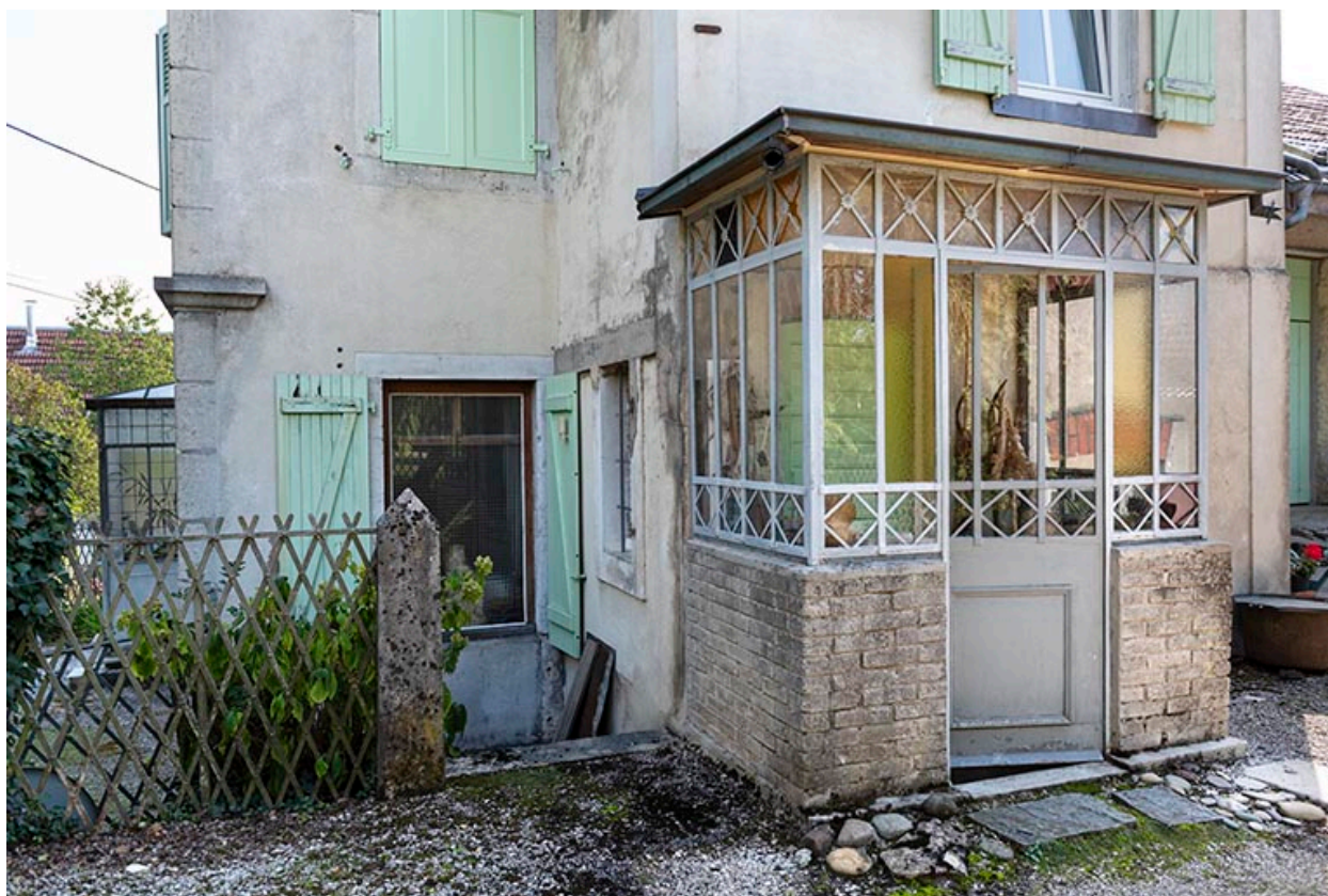
Logement Hugoniot : véranda nord, de trois quarts.
