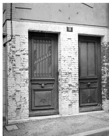
Portes d'entrée. Phot. Jérôme Mongreville IVR43_19923900783X
